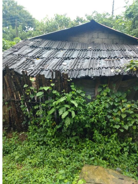
Ilustración 3.4.1. Fotografía de la vivienda actual de Huehuetla. Tomada por autor.
