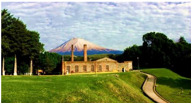
Figura 1.3 Fábrica textil “Metepc” Atlixco, Pue.
