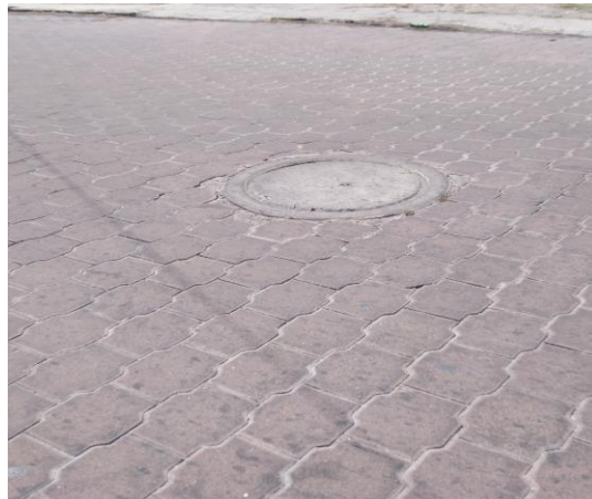
(Foto 13. Desagüe de la Calle Xicohtécatl Norte, Lancho R., 2019)
