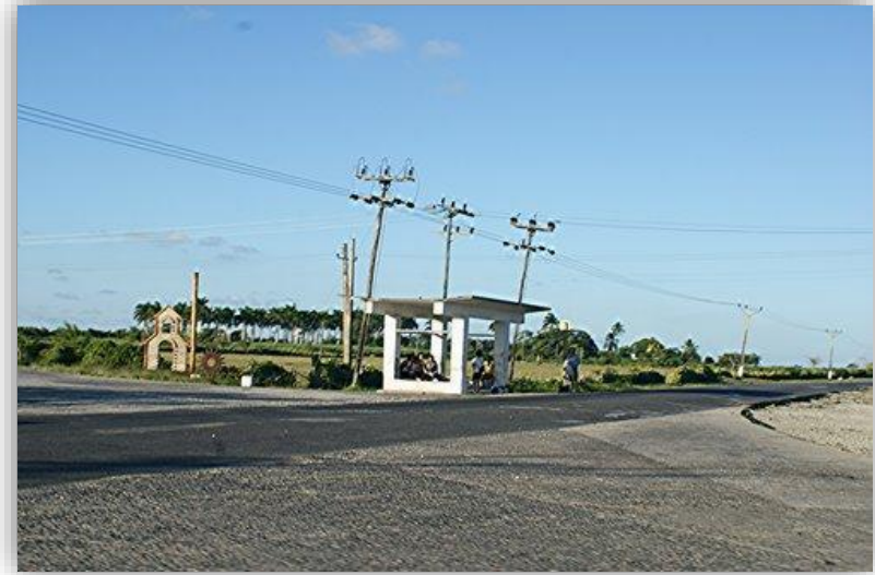
Carretera de Nuevitas a Camagüey en el entronque con la que conduce a la Playa de Santa Lucia.
