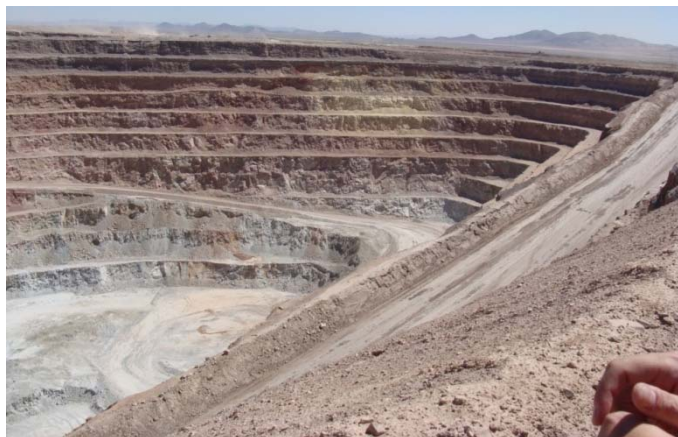
Figura 2.5. Tajo mineros, para el desarrollo de estos se requiere del análisis de estabilidad, se evalúan condiciones de falla en de cuñas y caída de rocas
