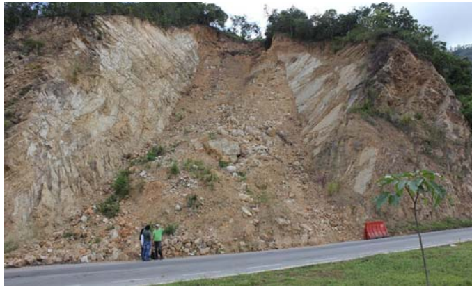
Figura 2.4. Ejemplo de unas cuñas reales en una carretera tal y como se observa en la imagen
