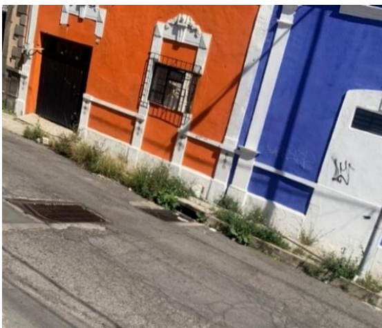
Imagen 13 Condición actual del área peatonal Fuente: Recorridos de campo, Cruz, López, 2024.
