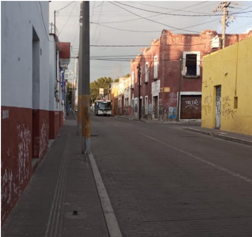
Imagen 15. Condición actual del área peatonal Fuente: Recorridos de campo, Cruz, López, (2024).
