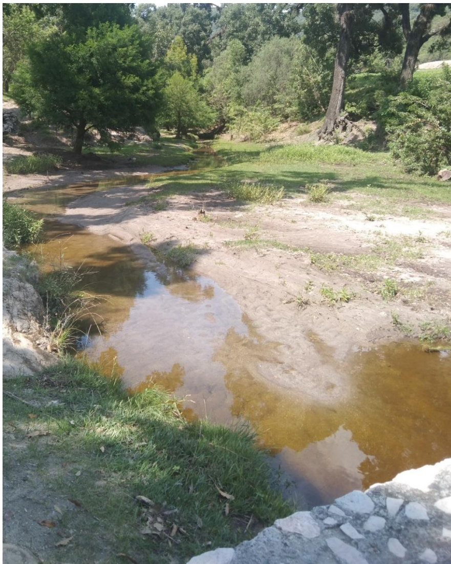
Imagen 2. Asolvamiento en las represas dentro del cauce.
