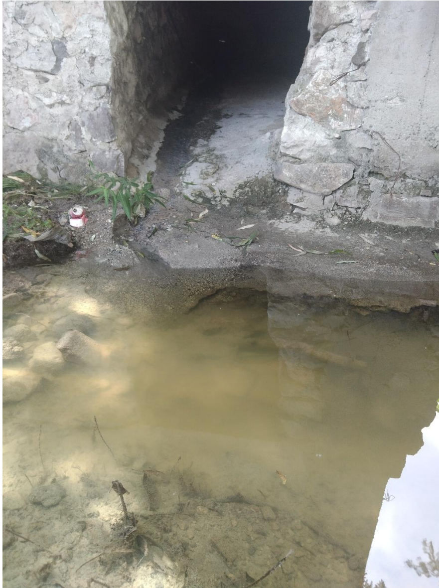
Imagen 29. Punto de muestreo A-4. Desagüe a cielo abierto.
