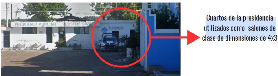
Figura 25. Primera ubicación de salones bachiller Benito Macias Zarate, Autoría (2023)
