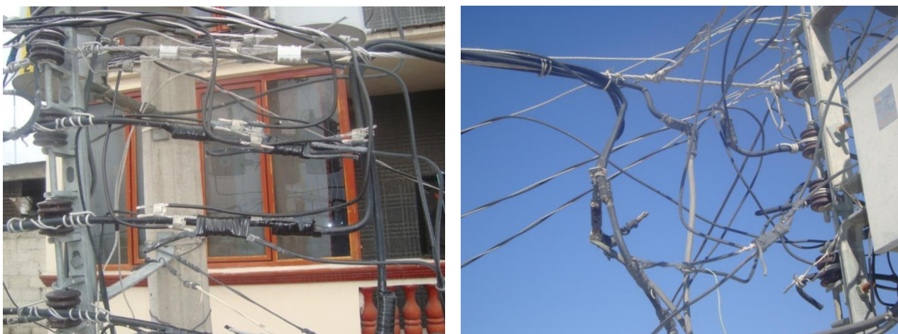
Imagen 55. Rehabilitación de la red en baja tensión.
