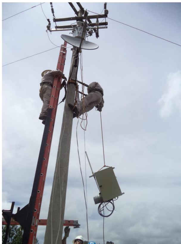
Imagen 66. Instalación de la antena satelital, kit de comunicación, medidor colector y antena yogui en estructura con transformador exclusivo para la alimentación del equipo.
