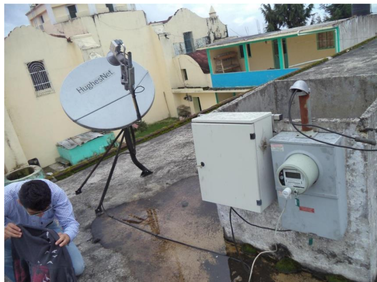
Imagen 59. Medidor colector, kit de comunicación y antena satelital instalados en una de las partes más altas de la población de Huaxcaleca.
