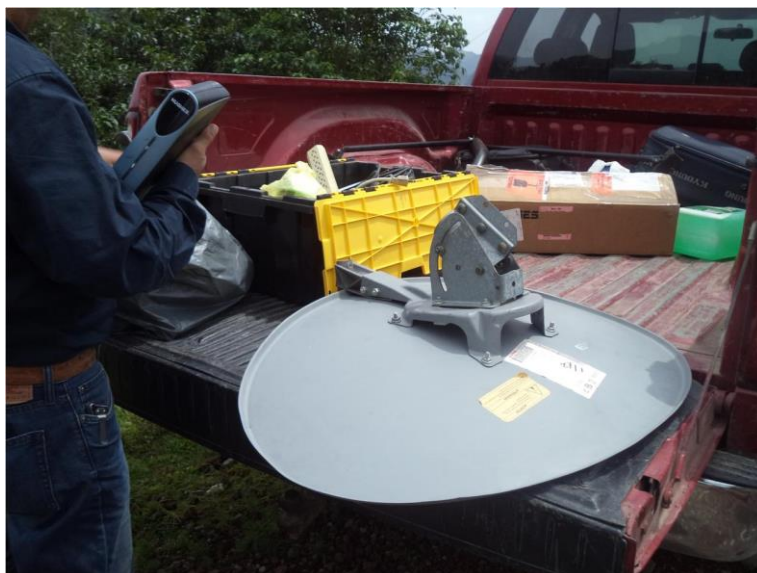
Imagen 64. Armado del kit de comunicación y antena satelital para el colector de la segunda etapa.
