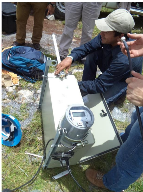
Imagen 65. Armado del medidor colector con el kit de comunicación y la antena yogui que servirá para comunicarse con otros medidores colectores por radiofrecuencia y así poder enviar la información de lecturas de los medidores esclavos por medio de la antena satelital al sistema MAS.
