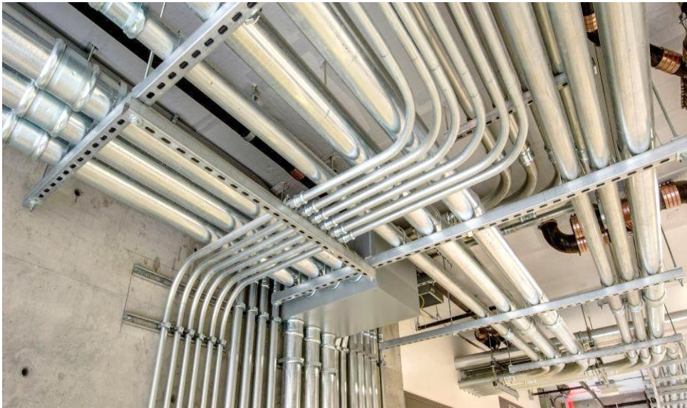
Ilustración 106. Ejemplo de Instalación Eléctrica con tubo Conduit
