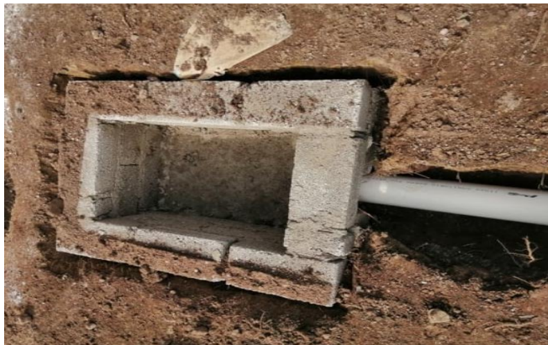
Ilustración 105 Detalle de un registro ciego Fuente: https://arqzon.com.mx/2022/12/17/registro-en-instalaciones-sanitarias
