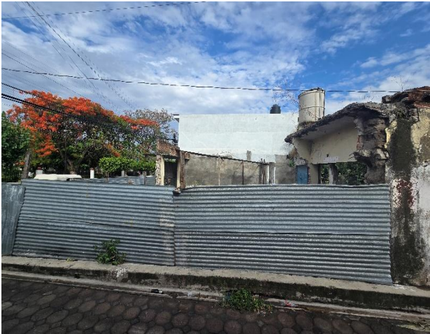
Ilustración 72 Vista de la lámina provisional de protección del terreno Fuente: Alejandro Flores (2025).
