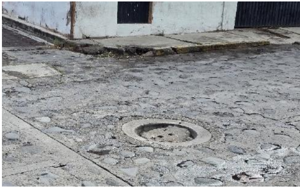
Ilustración 68 Pozo de visita Av. Galeana. Fuente: Alejandro Flores (2025).
