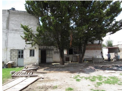
Ilustración 57- Granja Iglesia, Casa Alto Refugio. Autora: Michelle Castillo Moran, Samsung a03 core, 24/08/22. La infraestructura que se muestra en la imagen era de una iglesia, pero por el momento solo es un lugar para guardar distintos materiales de construcción o desechos.
