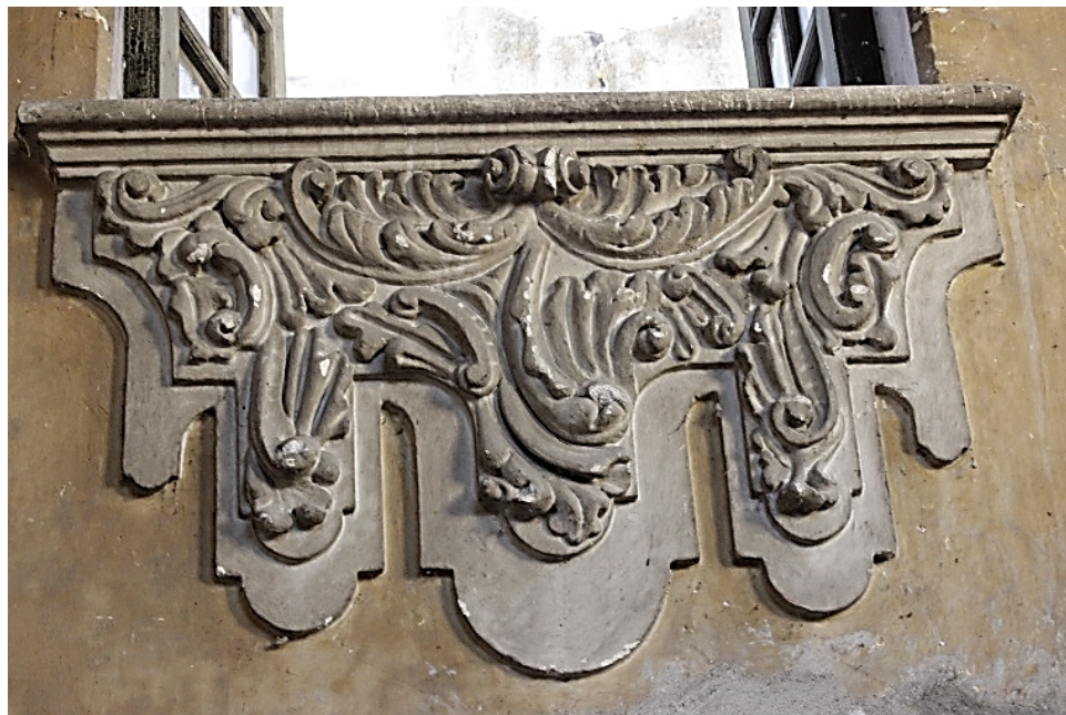
Figura 54. Detalle De Guardamalletas En Ventana De Cubo De Escalera Principal. Fuente: Elaboración Propia (2012), Puebla, México. [Figura]
