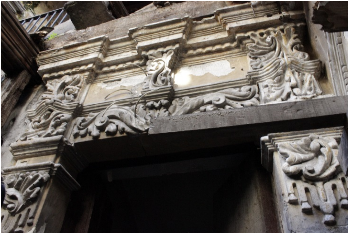
Figura 41. Detalle De Argamasas En Vano De Escalera. Fuente: Elaboración Propia (2012), Puebla, México. [Figura]
