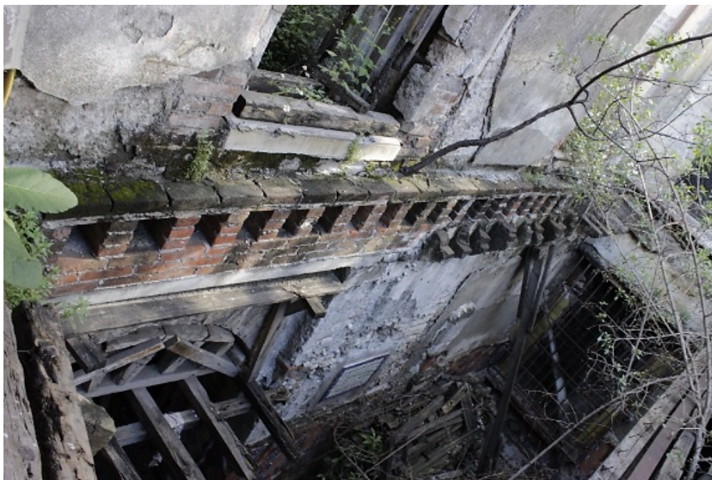
Figura 55. Mechinales En Lo Que Era La Cubierta De La Segunda Crujía. Fuente: Elaboración Propia (2012), Puebla, México. [Figura]
