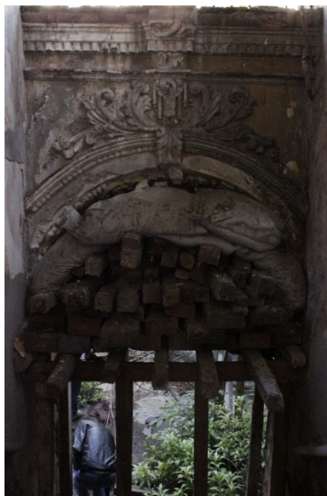
Figura 49. Vista Posterior De Escalera Principal. Fuente: Elaboración Propia (2012), Puebla, México. [Figura]
