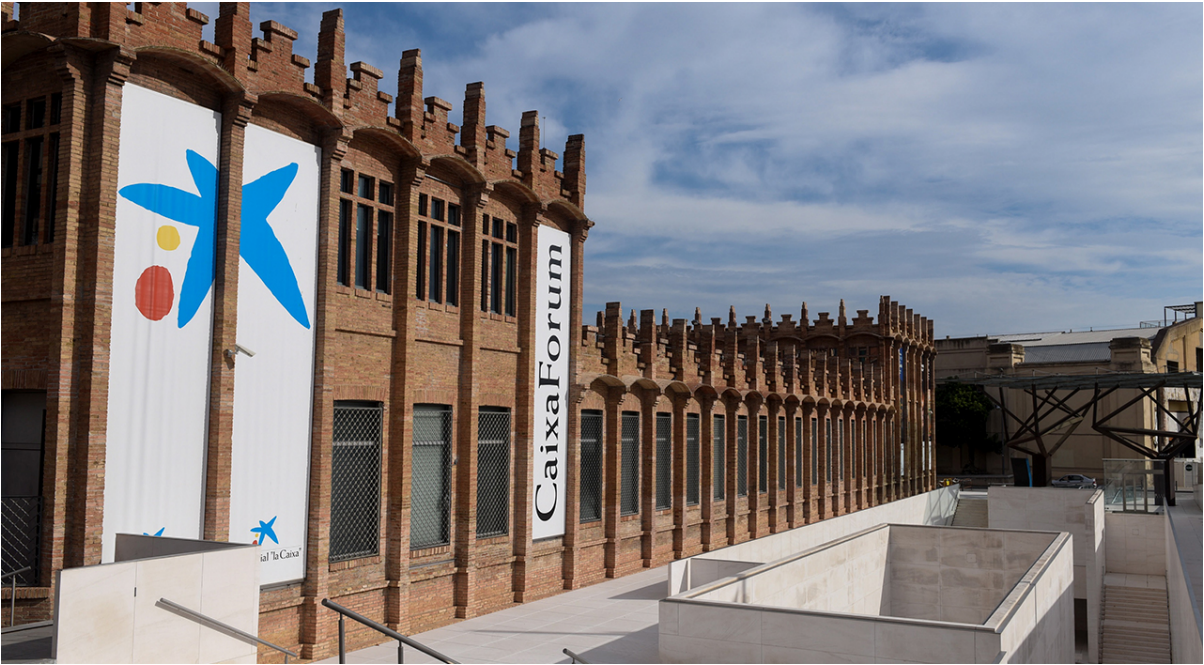
Figura 15. Fachada lateral del Caixa Barcelona. Fuente: Fundación Bancaria La Caixa. (2019) Caixa Forum Barcelona. [Figura] Recuperado de: https://caixaforum.es/es/barcelona/visitanos
