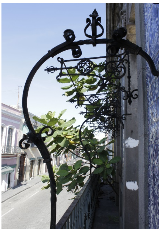
Figura 57. Detalle De Jabalcón En Balcones De Fachadas. Fuente: Elaboración Propia (2012), Puebla, México. [Figura]
