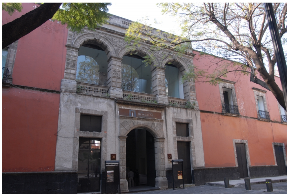
Figura 20. Fachada Principal del Centro Cultural. Fuente: ©Centro Cultural del México Contemporáneo. Centro Cultural del México Contemporáneo, Distrito Federal, México. [Figura] Recuperado de: https://www.ccmc.org.mx/secciones.php?cat=443
