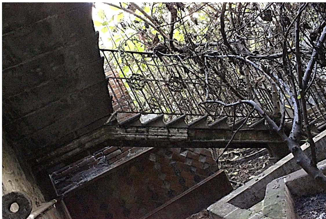
Figura 48. Vista Lateral De Escalera En Patio. Fuente: Elaboración Propia (2012), Puebla, México. [Figura]
