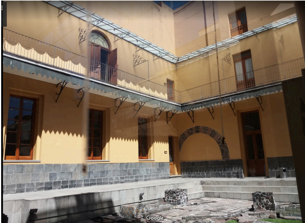
Figura 18. Patio del Centro Cultural X Teresa. Fuente: Villafaña W. (2019) Conversión del Antiguo Convento de San José y el Templo de Santa Teresa la Antigua a Galería Ex Teresa Arte Actual [Figura] Recuperado de: https://www.google.com/maps/@19.4339833,99.1306442,3a,75y,90t/data=!3m8!1e2!3m6!1sAF1QipPut7E5NN0gEZgJ7-wbS27ohC3n2UrjU7jIrNLQ!2e10!3e12!6shttps:%2F%2Flh5.googleusercontent.com%2Fp%2FAF1QipPut7E5NN0gEZgJ7-wbS27ohC3n2UrjU7jIrNLQ%3Dw365-h273-k-no!7i4128!8i3096
