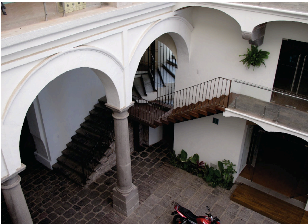
Figura 33. Vista Hacia Una De Las Escaleras. Fuente: ©Casa del Mendrugo. Casa del Mendrugo, Puebla, México. [Figura] Recuperado de: https://embed.culturalspot.org/embed/asset-viewer/vista-desde-el-segundo-piso-de-la-casa-del-mendrugo-después-de-la-restauración/VwHSenQnGJhMTg?exhibitId=EwKipFZ
