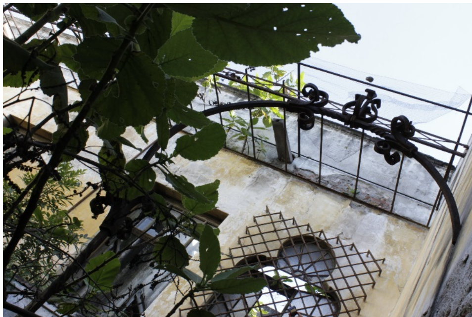
Figura 56. Detalle De Jabalcón En Escalera De Patio Central. Fuente: Elaboración Propia (2012), Puebla, México. [Figura]
