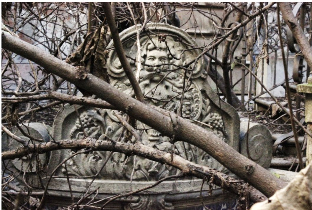
Figura 45. Detalle De Fuente En Patio. Fuente: Elaboración Propia (2012), Puebla, México. [Figura]
