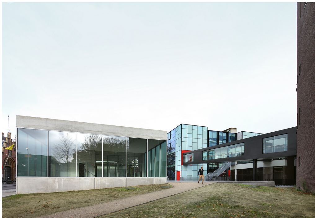
Figura 8. Vista lateral del Centro de Producción de Artes. Fuente: Dujardin F. (2013) Conversión de Track Tower al Centro de Producción de Artes de Stéphane Beel y Lieven Achtergael. Kortrijk, Bélgica. [Figura] Recuperado de: https://archello.com/story/31314/attachments/photos-videos/2
