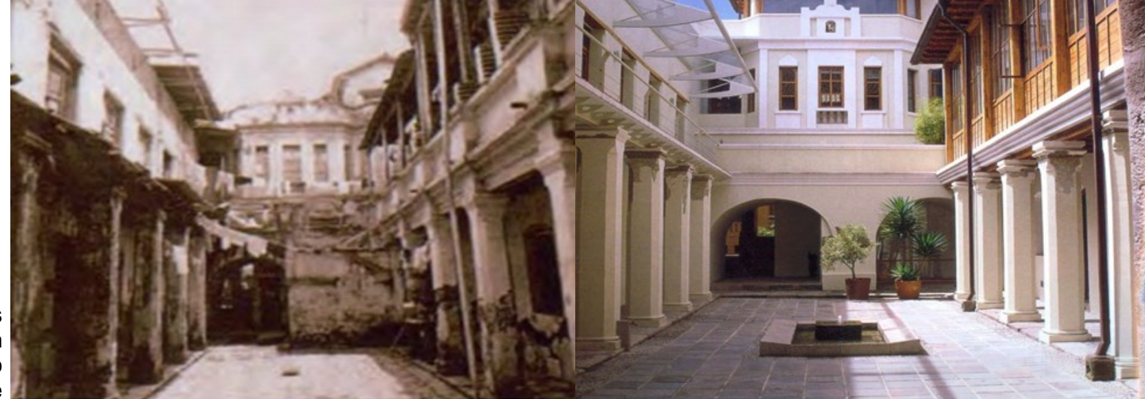
Ilustración 2. Patio de la casa caldas 508, en el centro histórico de Quito, antes de su rehabilitación. Ilustración 3. Patio de la casa caldas 508, en el centro histórico de Quito, después de su rehabilitación.
