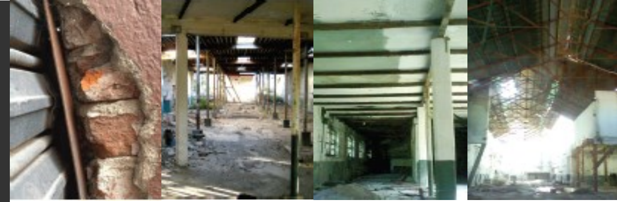
1. Muro de Carga
