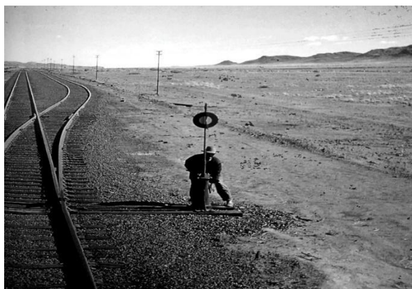
Imagen 42. Cambiador accionando el cambio Ferrocarriles Nacionales de México. (1996). Caminos de hierro , p.105.
