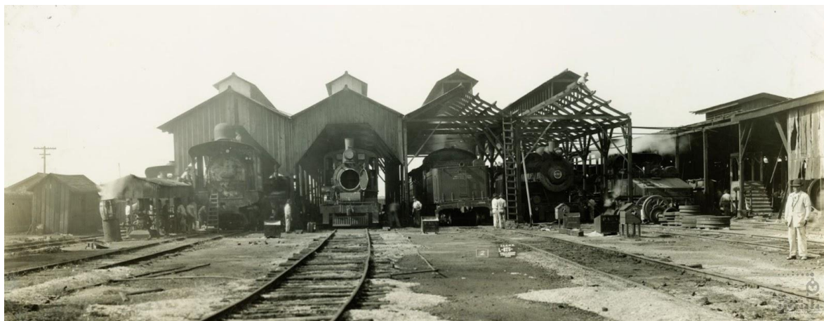
Imagen 50. Casa de máquinas
