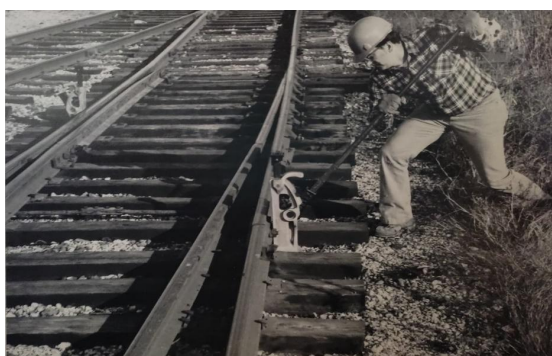
Imagen 82. Hombre utilizando el gato de vía Templeton, Kenly & CO. (1982). Simplex cylinders, pumps, jacks, pullers , p.5.
