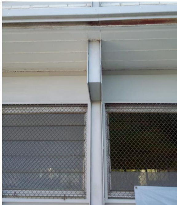
Figura. 3.2.1.1.1.3 Columnas de sección transversal compuesta
