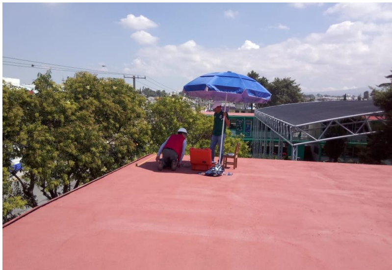
Figura 3.1.2.3. Lectura en esquina de azotea.
