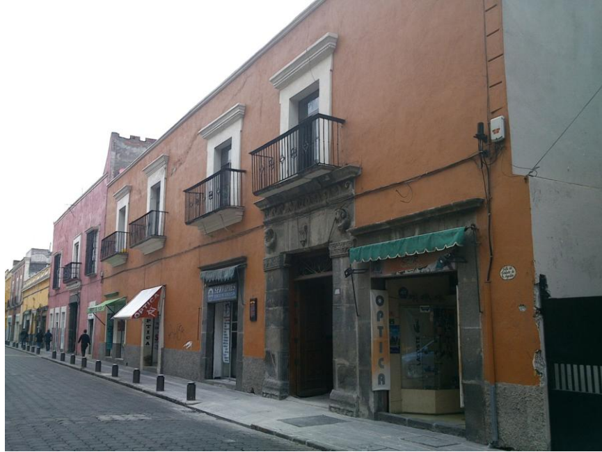
Av. 3 Poniente No. 512 (Casa de las Cabecitas)
