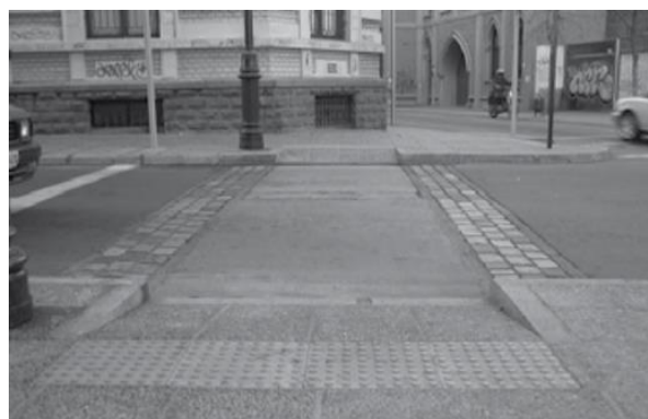
Ilustración 31 Rebaje con buen uso de texturas y diferenciación de pavimentos. Santiago, Chile.
