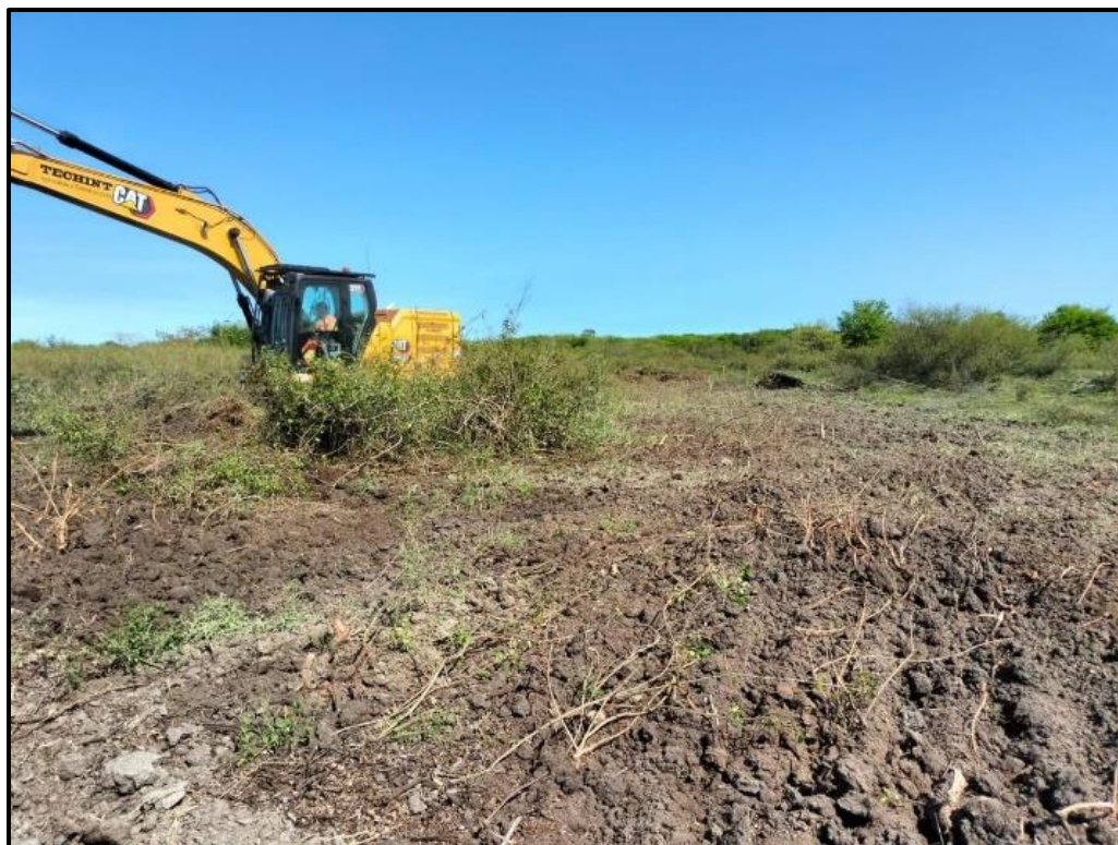
Figura 43. Desmonte en la zona a trabajar con máquina excavadora.
