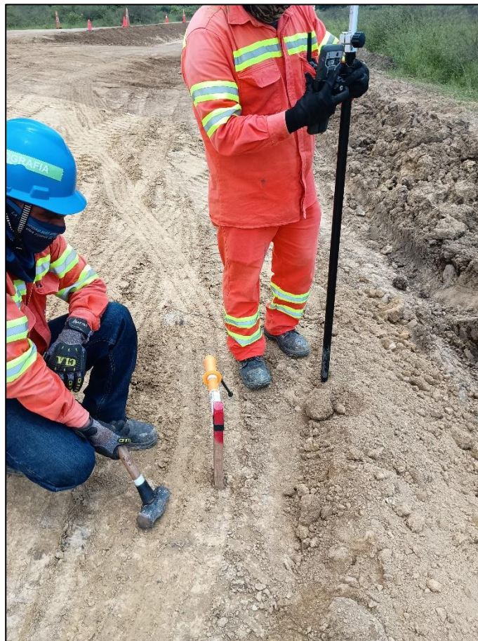
Figura 39 Colocación de estacas con GPS en zona a trabajar.
