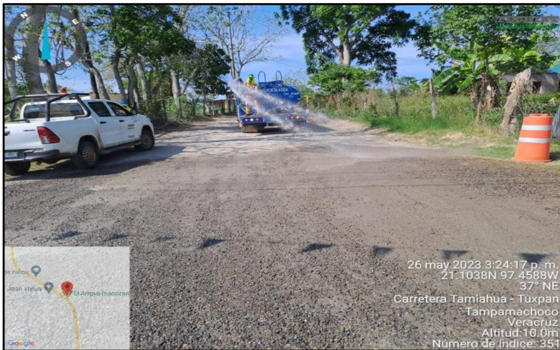
Figura 47. Humectación del Terreno.
