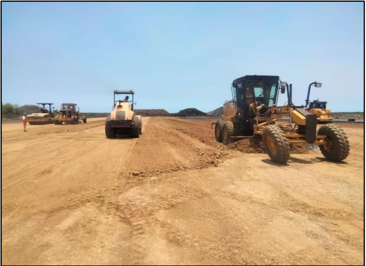
Figura 46. Tendido de material por capas mediante una moto conformadora.
