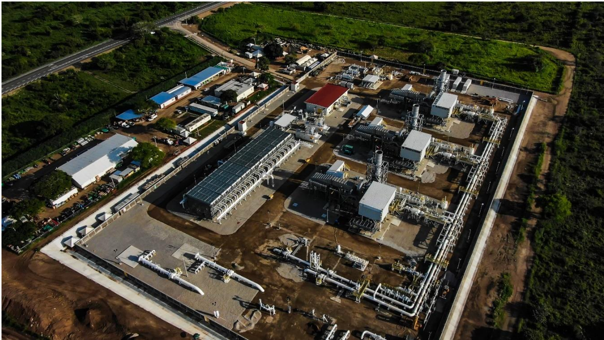
Figura 27. Estación de Compresión Altamira 2018 (ECA) concluida.
