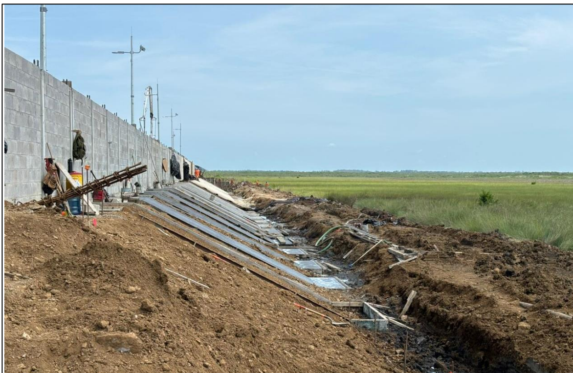
Figura 51 Construcción de taludes en ECVN
