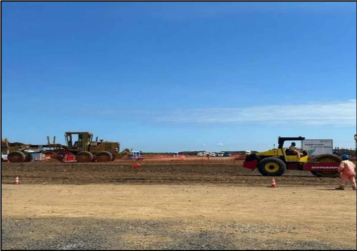
Figura 48. Vibro-compactador utilizado para alcanzar la compactación del terreno.
