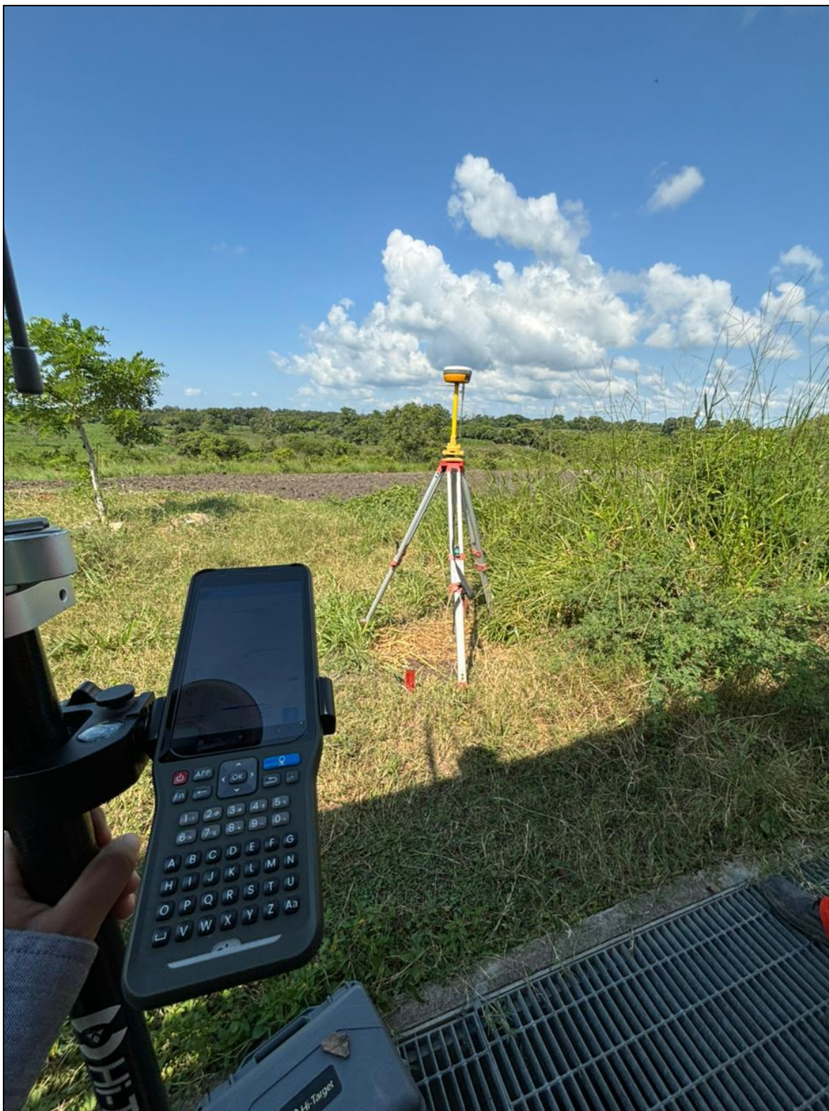
Figura 55 Replanteo de Puntos con GPS Hi Target GNSS RTK
