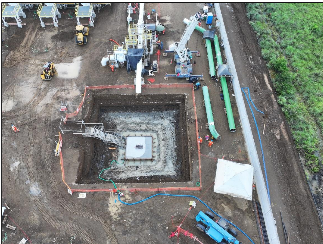
Figura 56 Excavación realizada con apoyo topográfico.
