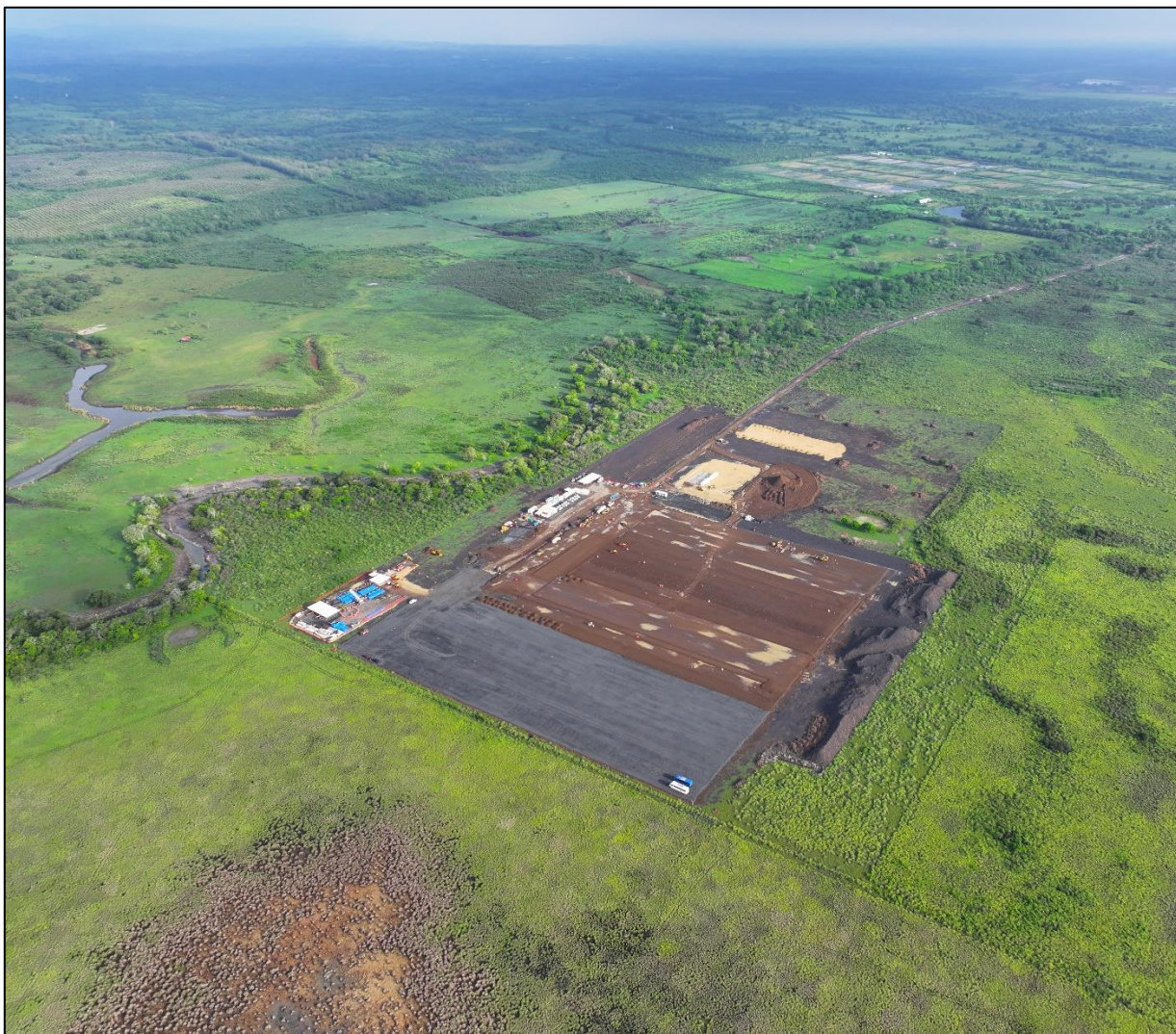
Figura 52. Fotografía tomada con Dron del inicio de terraplén de la ECVN.
