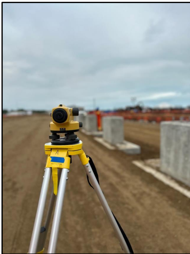
Figura 21. Nivelación de soportes para Air Cooler en ECVN.
