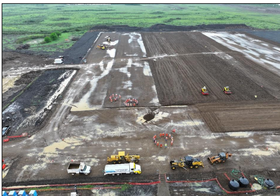
Figura 45. Tendido de capas y maquinaria utilizada.
