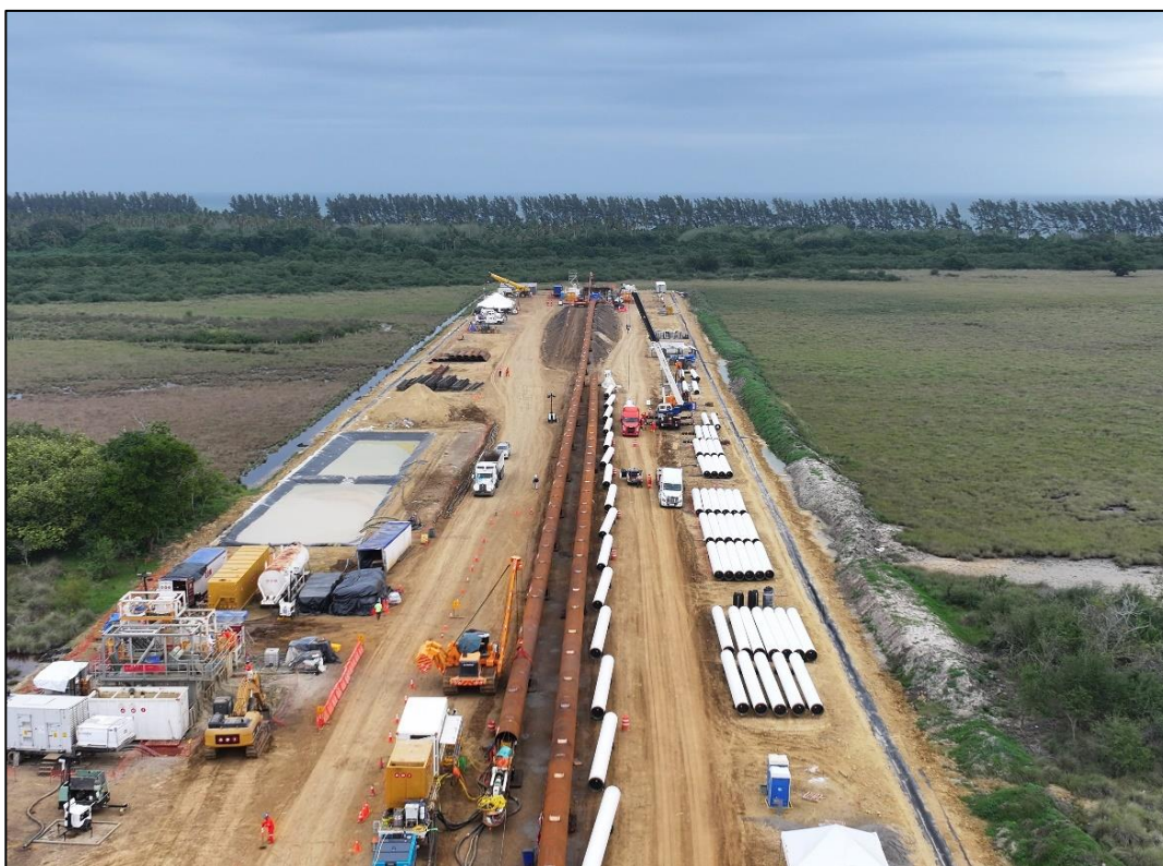
Figura 57 Desfile de Tubería para Construcción de Gasoducto.
