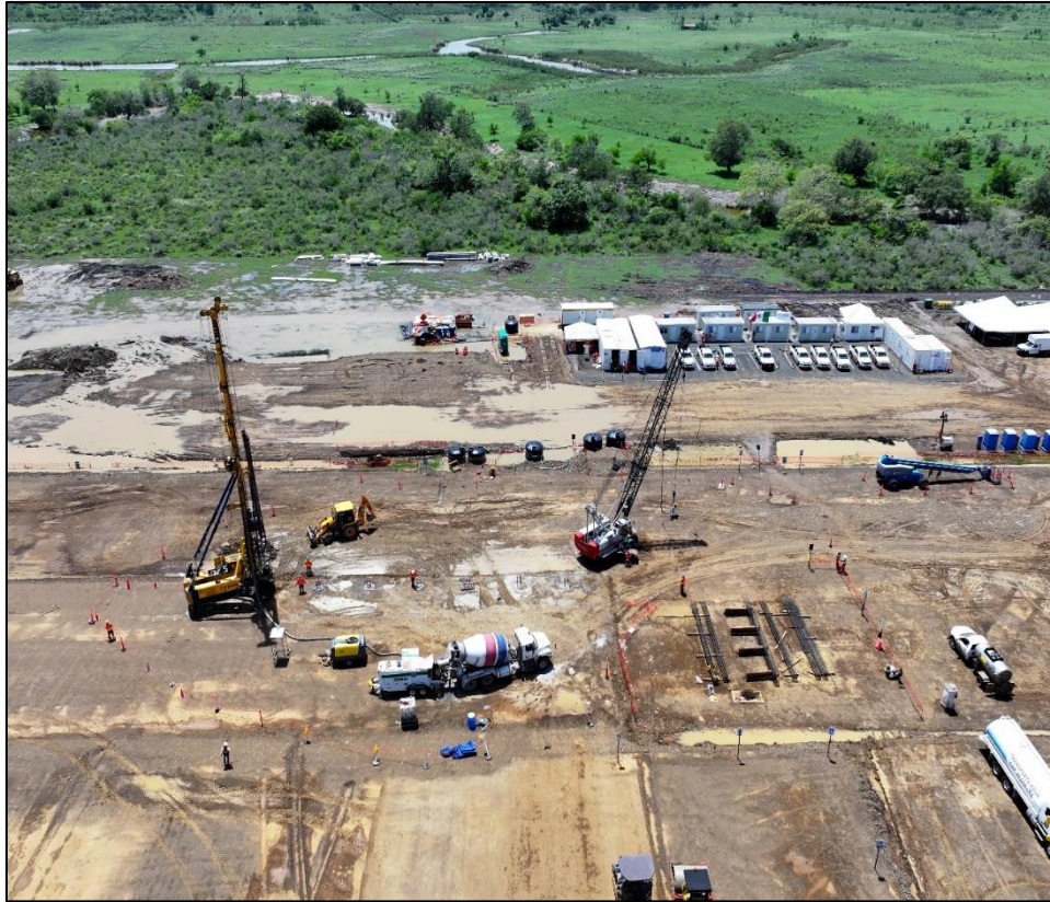
Figura 53. Mejoramiento de Suelos con DVP y CMC
