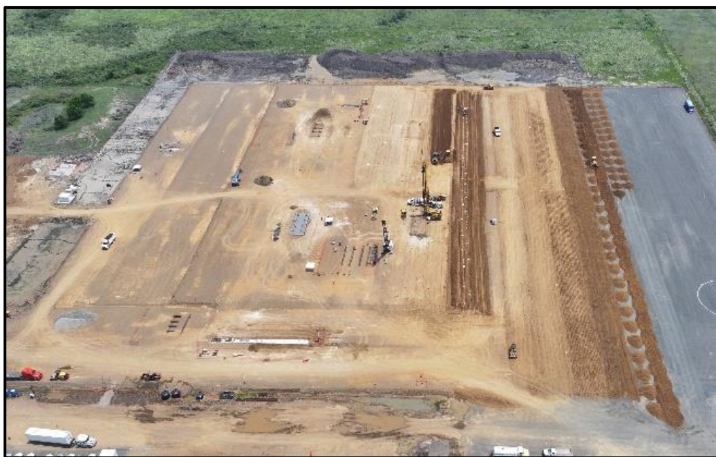
Figura 25 Colocación de material para tendido de capas.
