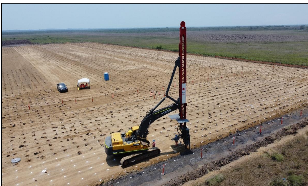
Figura 34 Sistema de Mejoramiento de Suelos en ECVN
