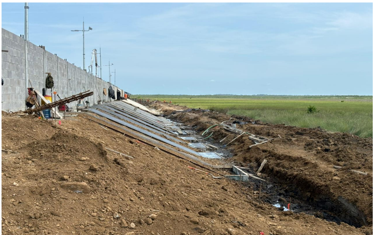
Figura 61 Construcción de taludes.
