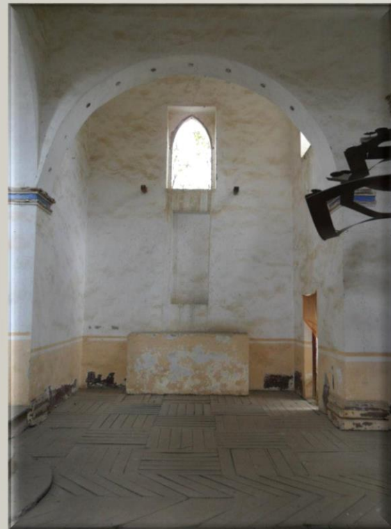
Ilustración 12 interior Capilla Hacienda Santa Bárbara (vista al altar)
