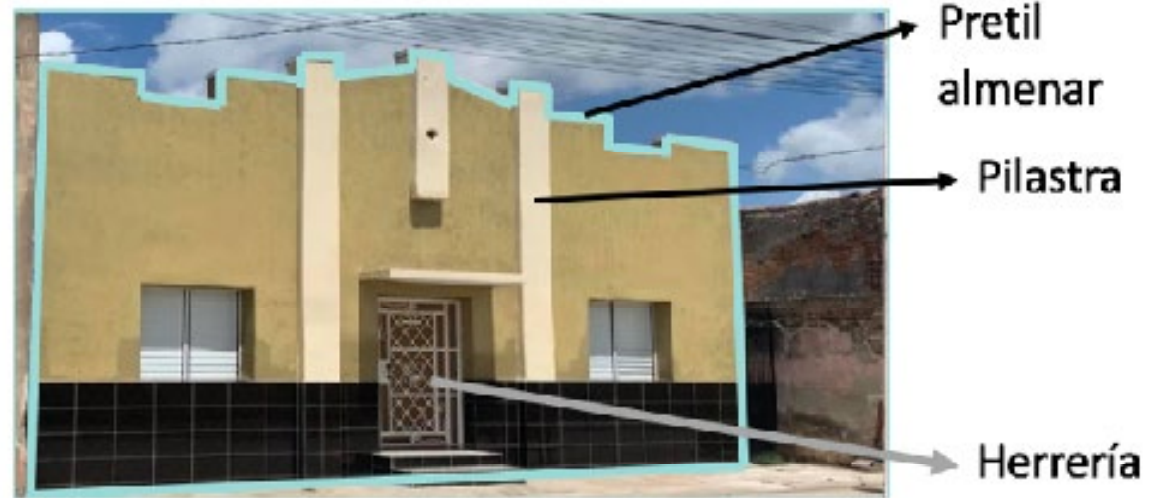
Figura 116 Línea urbana del contexto del predio
