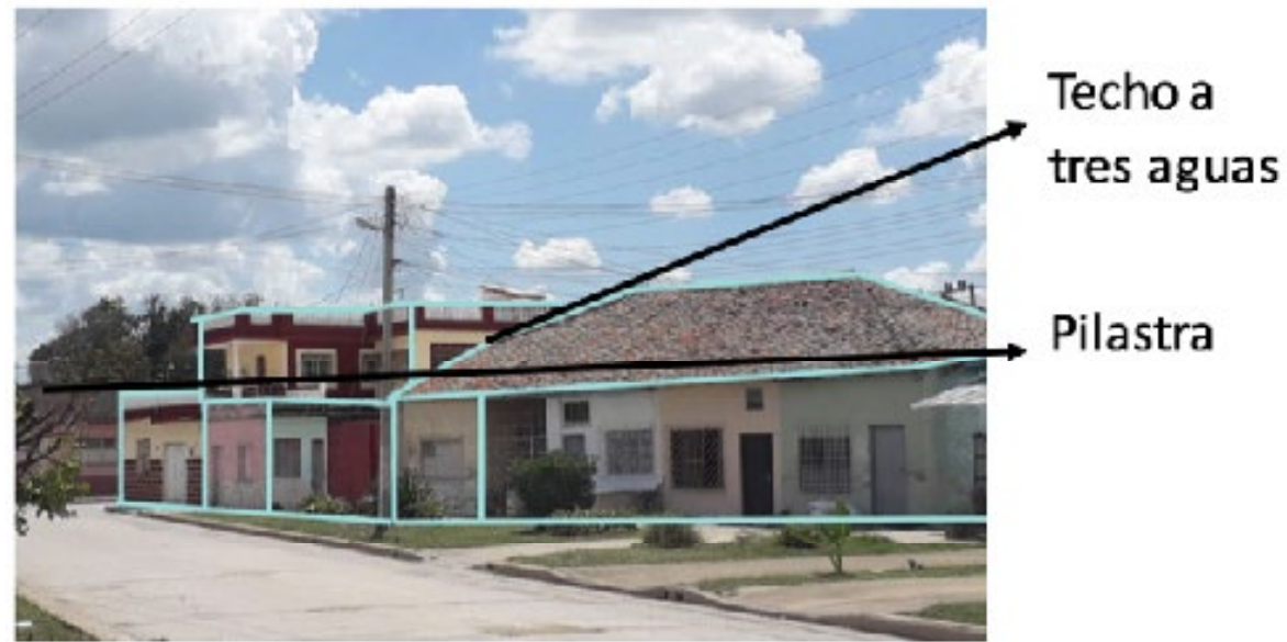
Figura 117 Línea urbana del contexto del predio
