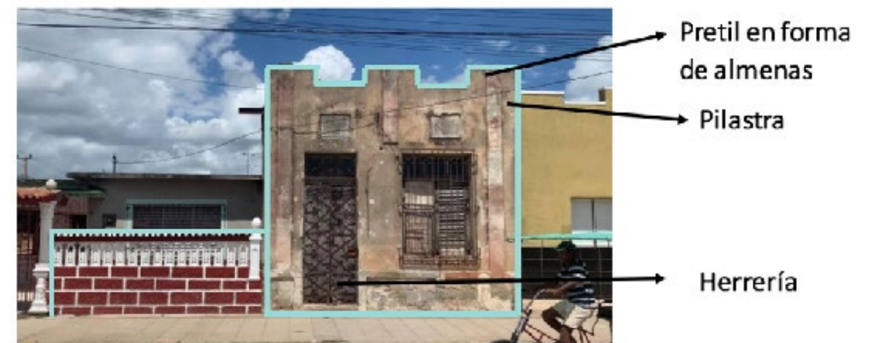
Figura 115 Línea urbana del contexto del predio
