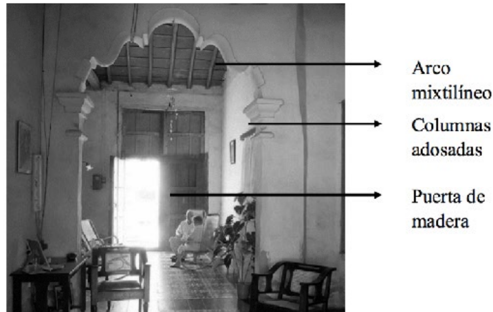
Nota. Esta fotografía fue tomada desde el interior de una casa tradicional en Camagüey, Cuba. Fuente: Weiss J.E. (1979). La arquitectura colonial cubana. Letras cubanas, La Habana.
