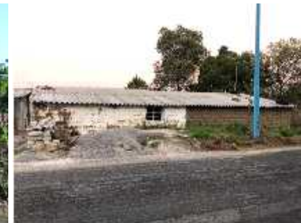
Casa de Adobe en Cuamilpa, Tlaxcala. Fotografía de Rolando Ubieta Ramírez
