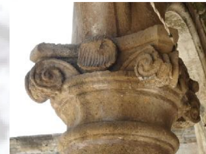
Imagen 41. Detalle de columna
