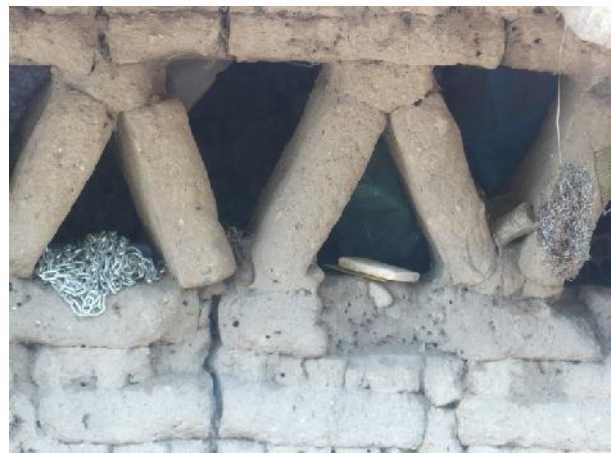
Fotografía 35. Detalle de celosía con adobe.
