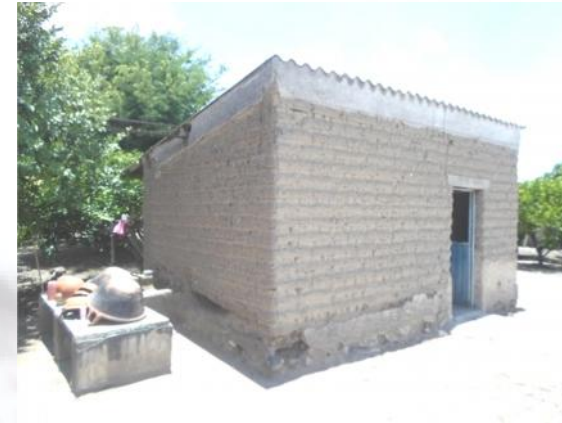
Fotografía 37. Vivienda con techo inclinado
