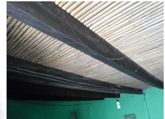
Fotografía 98. Vigas en buen estado.
