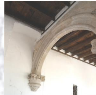
Fotografía 12. Viguería de madera del deambulatorio
