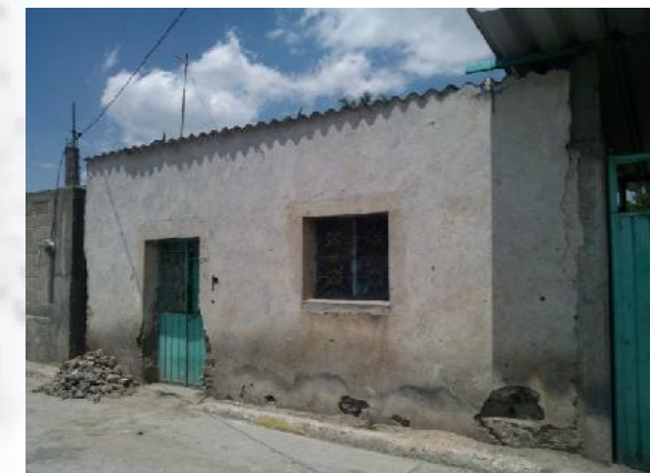
Fotografía 32. Herrería de ventana y puerta.
