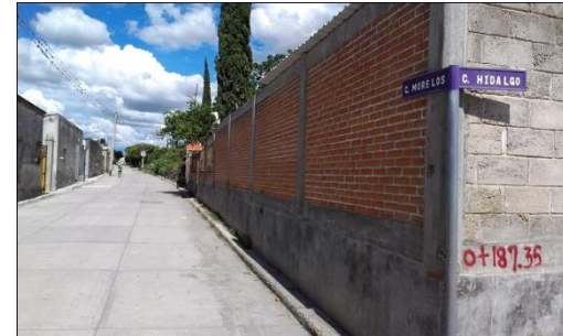
Fotografía 81. Calle Morelos: Tramo 1-D
