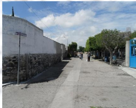
Fotografía 52. Inexistencia de banquetas.
