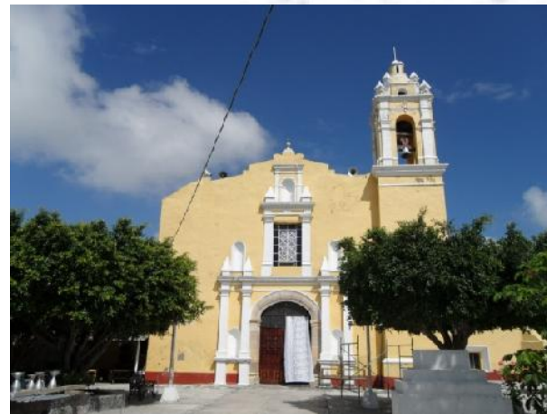
Fotografía 17. Fachada de la iglesia
