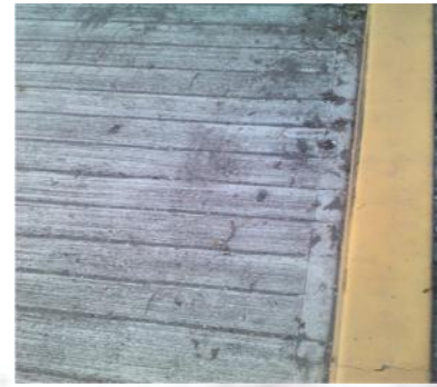
Fotografía 55. Concreto estampado (rayado)
