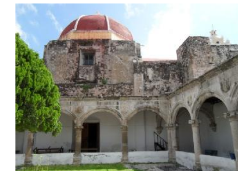
Fotografía 61. Claustro del ex convento
