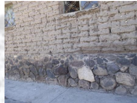
Fotografía 25. Desplante de vivienda.
