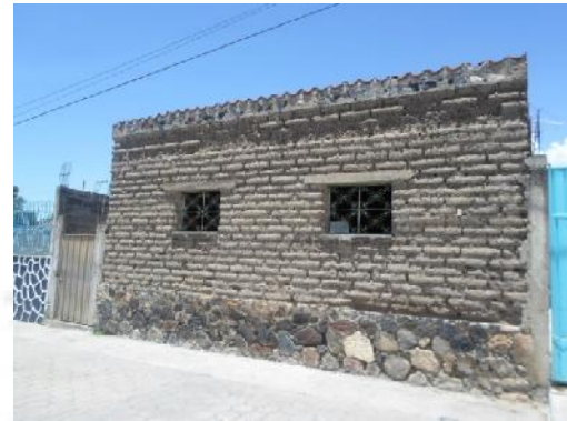
Fotografía 28. Fachada de vivienda de adobe
