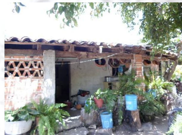
Fotografía 36. Celosía con ladrillos.
