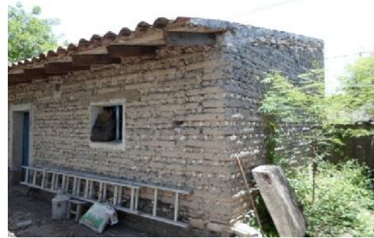
Fotografía 27. Bloques de adobe reforzados con pequeñas piedras.
