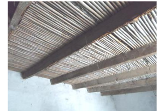
Fotografía 38. Detalle de vigas y carrizo.
