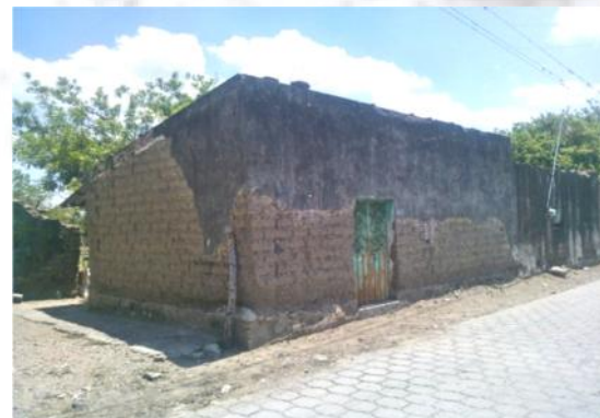
Fotografía 30. Fachada de vivienda de adobe
