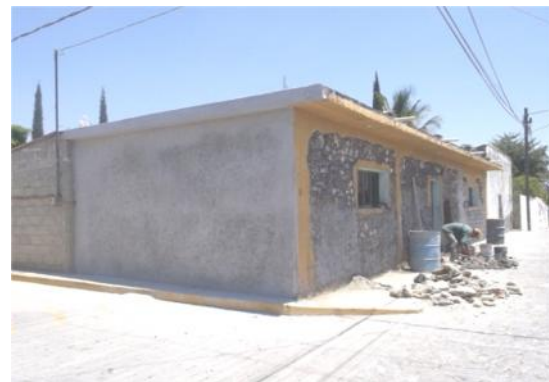
Fotografía 29. Mantenimiento de fachada.
