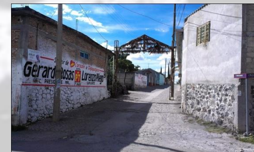
Fotografía 78. Calle Miramar: Tramo A-B
