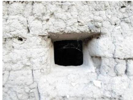
Fotografía 33. Detalle de vano de ventilación
