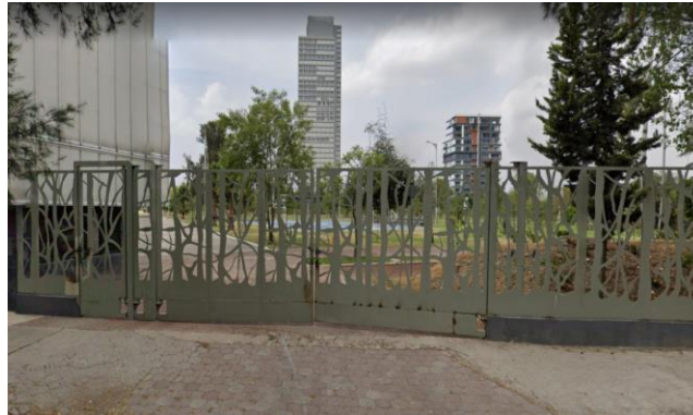
Figura 13. Detalle de la reja y acceso sobre Boulevard de Niño Poblano. No hay evidencia a la fecha de por qué no se ha habilitado este acceso al público en general, se mantiene cerrado con cadenas. Fuente: Google Maps 2020
