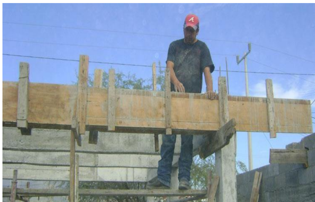
Figura 14 Proceso Constructivo Casa Cubierta. Recuperado de (Comunidad Vivex, 2016)
