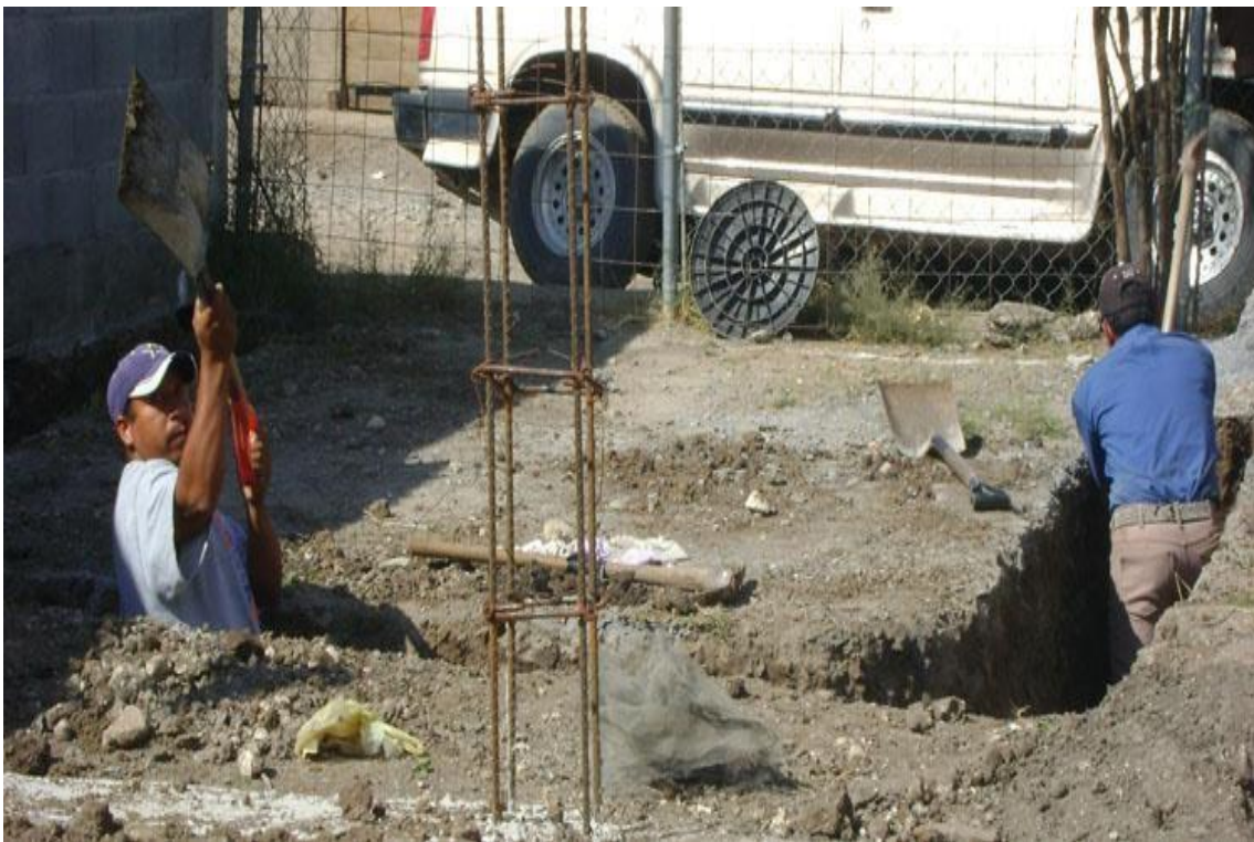
Figura 17 Proceso de Cimentación Casa Cubierta. Recuperada de (Comunidad Vivex, 2016)
