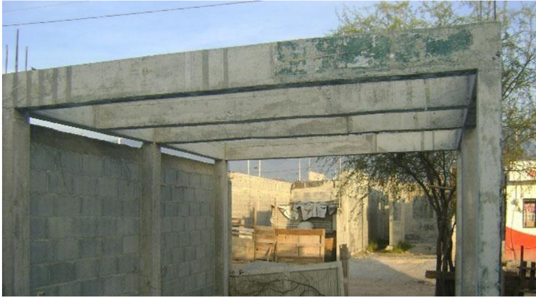
Figura 20 Proceso Constructivo Casa Cubierta. Recuperado de (Comunidad Vivex, 2016)
