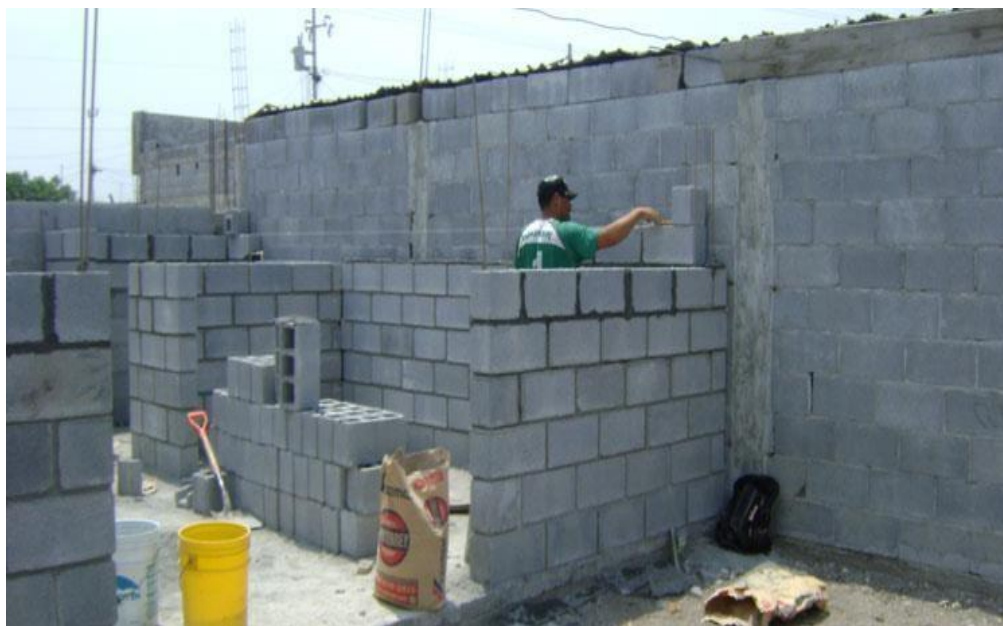
Figura 18 Proceso Constructivo Casa Cubierta. Recuperado de (Comunidad Vivex, 2016)
