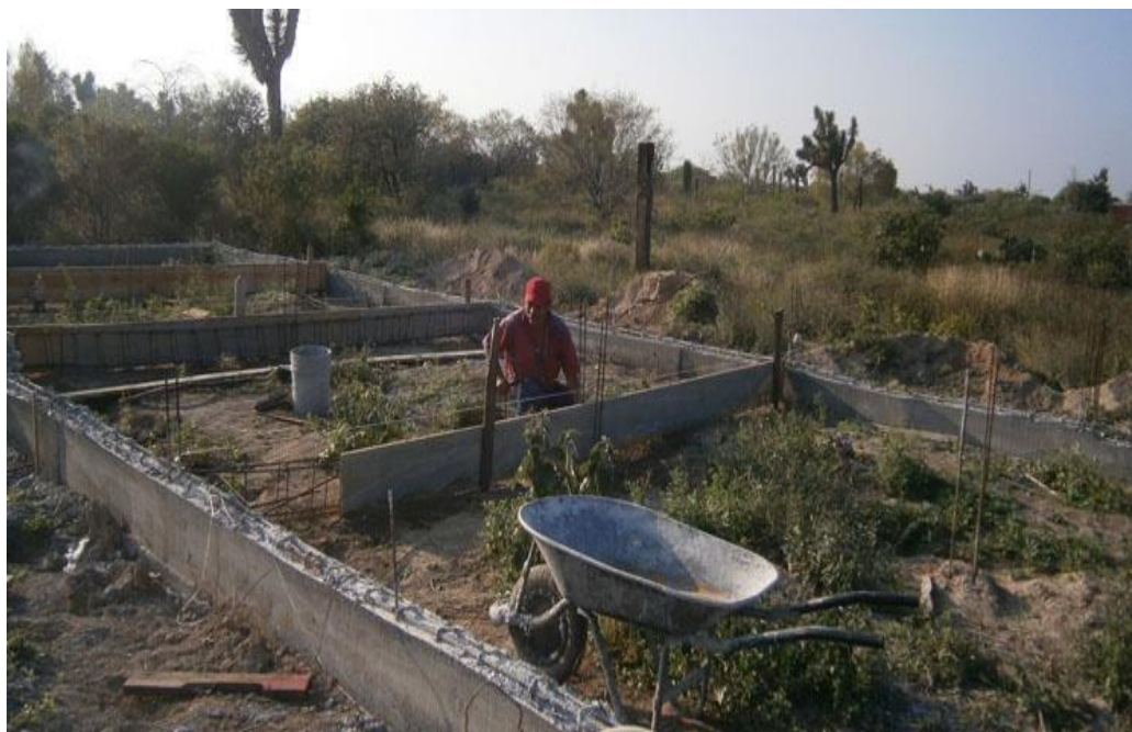
Figura 28 Cimentación Casa Cimbra. Referencia de (Comunidad Vivex, s.f.)
