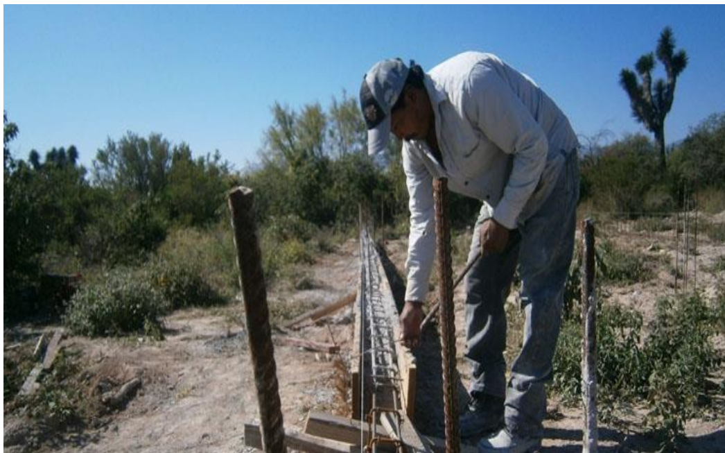
Figura 27 Cimentación Casa Cimbra. Referencia de (Comunidad Vivex, 2016)
