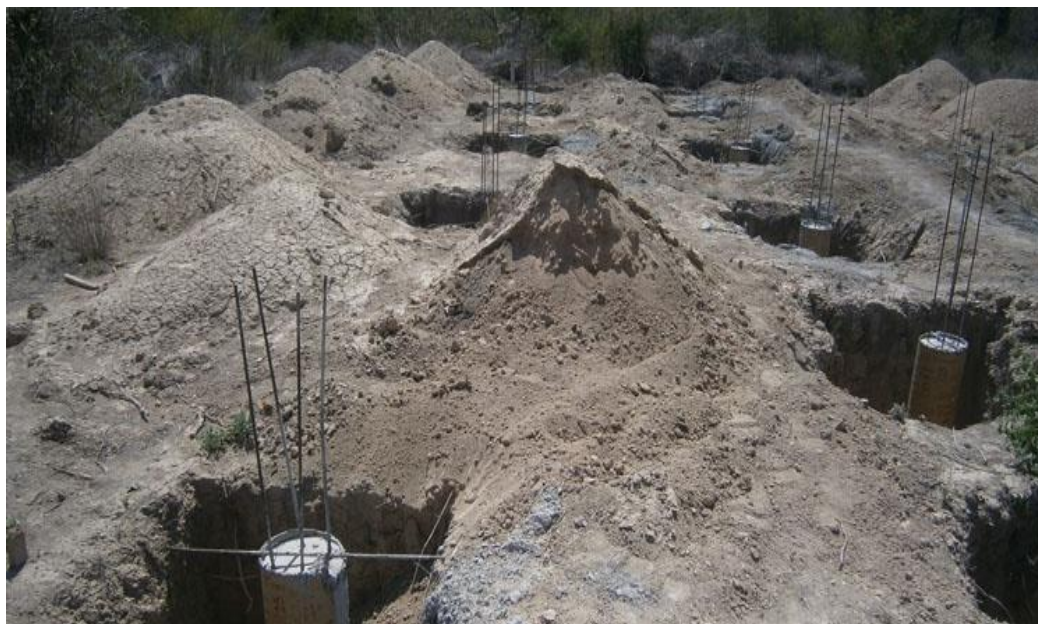
Figura 26 Cimentación Casa Cimbra. Recuperado de (Comunidad Vivex, s.f.)
