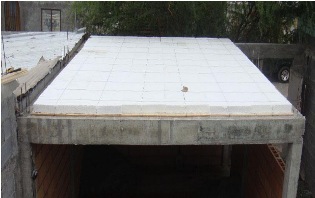
Figura 21 Proceso Constructivo Casa Cubierta. Recuperado de (Comunidad Vivex, 2016)
