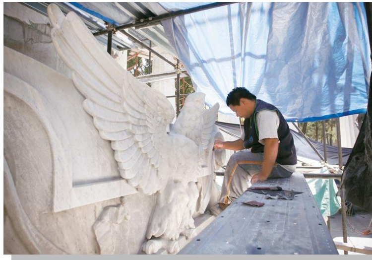
Ejemplo de Mantenimiento Correctivo Fuente: https://www.bing.com/images/search?q=monumentos+historicos.+limpieza&view
