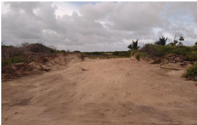
Fotografía 6: Duna desmontada para la construcción
