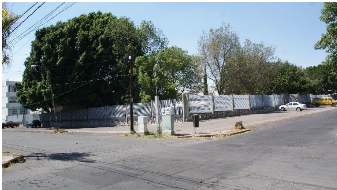
Fotografía 35. Casa de la cristiandad en 35 oriente y 18 sur. (2019). Fuente: Elaboración propia.
