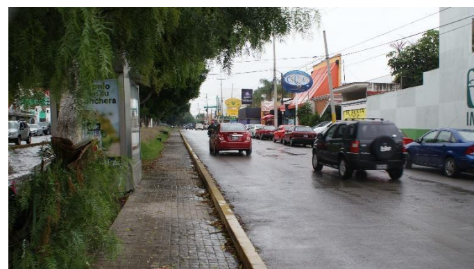
Fotografía 24. Avenida 18 sur (senda). (2019).
