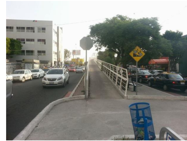
Fotografía 3. "Puente para bicicletas ubicado en la Avenida 14 sur. (2019). Fuente: Elaboración propia.
