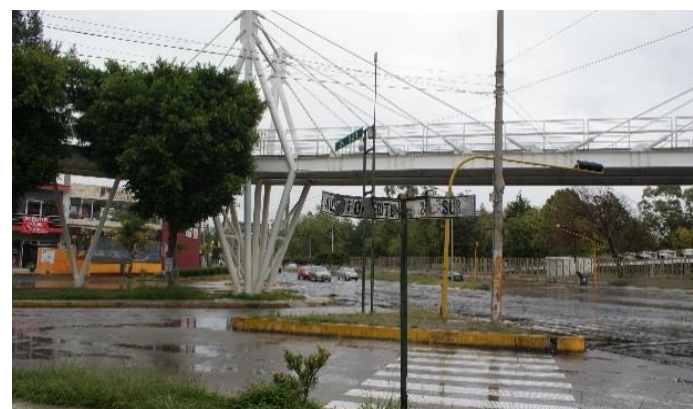
Fotografía 6. Puente peatonal en avenida 24 sur y 31 poniente. (2019). Fuente: Elaboración propia.
