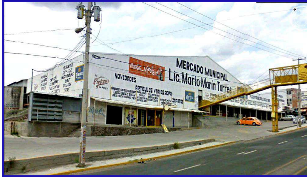
Foto 1: Fachada exterior del mercado municipal de San Francisco
