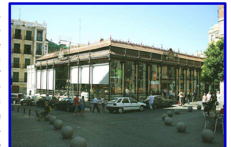
Foto 15: vista exterior del mercado de San Miguel Fuente: http://upload.wikimedia.org/mercado_de_san_miguel_2009
