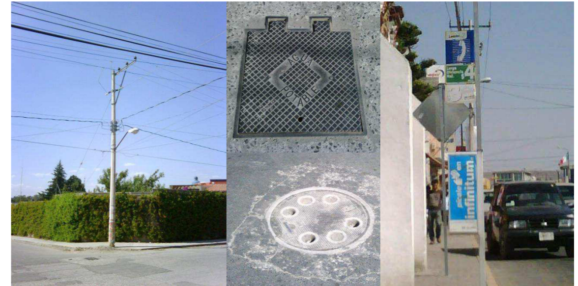
Foto 8: Infraestructura existente en la zona Fuente: Tomada por Tesista
