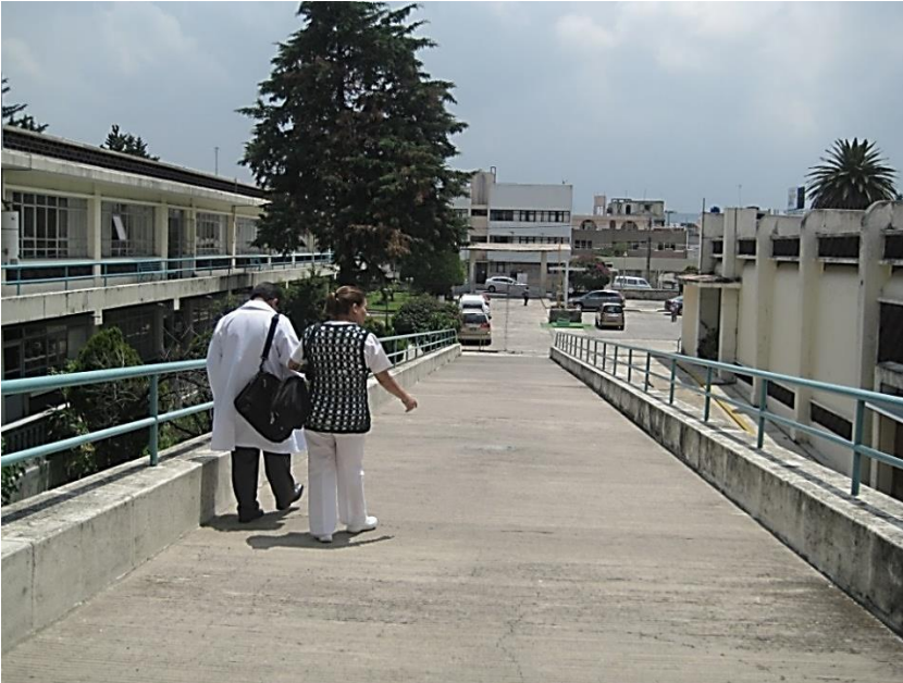
Foto 2. “La rampa”. Ésta rampa conecta la entrada y patio central con la puerta principal de la institución, pensada para el traslado de silla de ruedas y andaderas de sus residentes; cabe señalar la gran inversión económica que implica una rampa de estas dimensiones. Y es debido a las necesidades corporales de los adultos mayores que el espacio arquitectónico es adaptado con rampas, barandales, elevadores, pasamanos incrustados en la pared, agarraderas en los sanitarios e incluso más de una enfermería o el limitado uso de escaleras.
