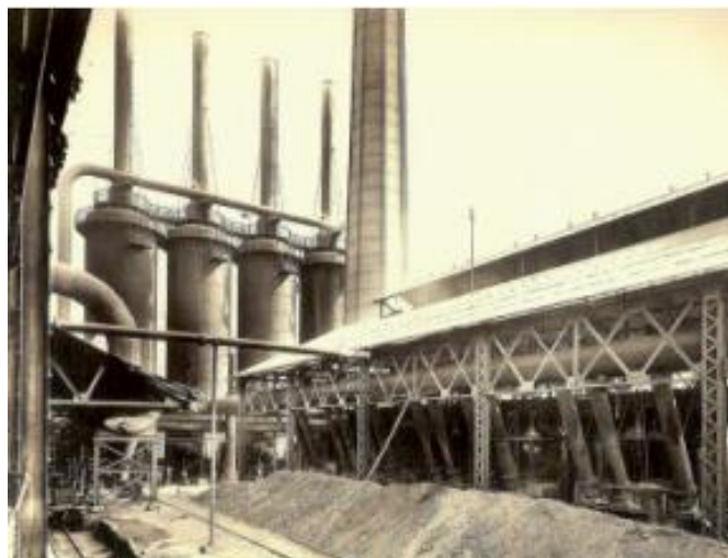
Figura 2. Vista de las estufas del Alto horno 1 de Fundidora Monterrey (A. Esquivel Herrera, Desarrollo de un aglutinante orgánico para la fabricación de moldes y corazones de arena, tesis doctoral, Univ. Nacional Autónoma de Nuevo León, 2010. [En línea]. Disponible en: http://eprints.uanl.mx/10352/1/36_altoshornos.pdf )
