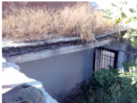
Imágenes 24 y 25. Losa Colapsada Fotos de: Guillermo E. Morales Alva. 2014
