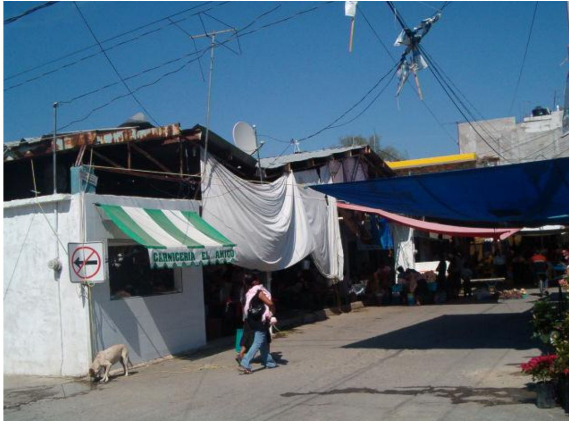
Imagen 14.- Vista del mercado municipal de Tehuiztingo, desde la calle Centenario, en donde se aprecia la nave principal del mercado y el posterior agregado. / Junio 2015 / MCLZ.
