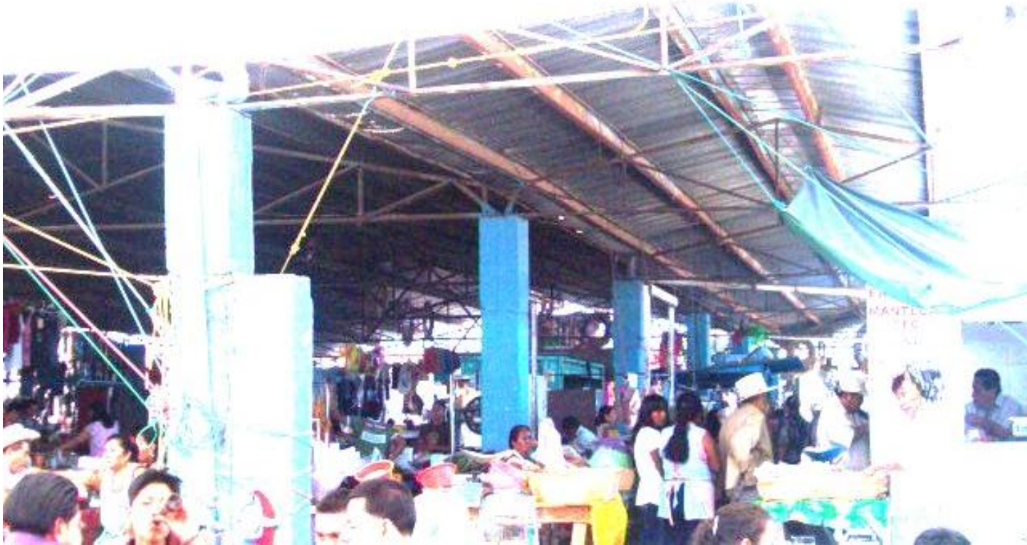
Imagen 17.- Vista del mercado desde la calle Zaragoza en donde se aprecia su estructura mediante cerchas del techo con lámina galvanizada, la cual se encuentra deteriorada y carente de mantenimiento/ Junio 2015 / MCLZ
