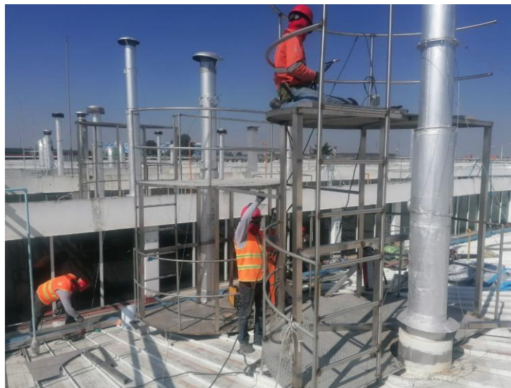
Figura 2.1.18. Ejecución de trabajos en altura con alta exposición de calor
