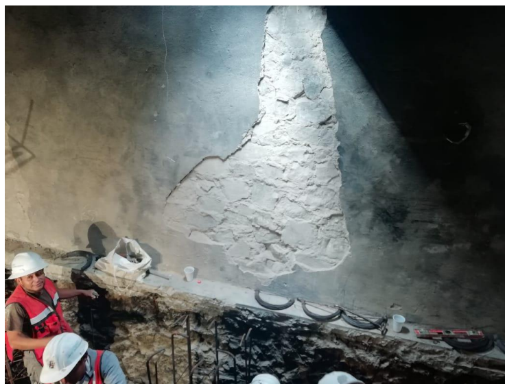
Figura 2.1.24. Trabajos de cimentación en espacio confinado
