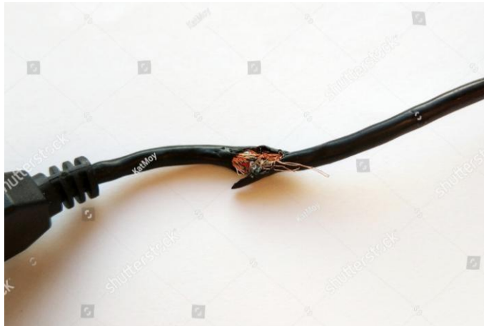
Figura 2.1.6. Cable eléctrico en mal estado
