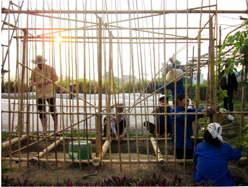
IMG 3.2.2.3 Proceso de construcción, Vegetable Nursery Hous, 1+1>2 Int.Arch. JSC (2013)
