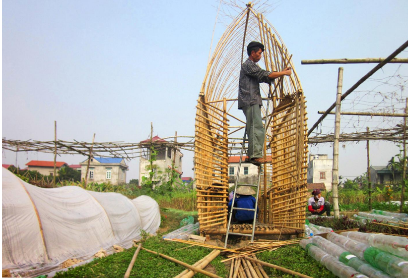
IMG 3.2.2.2 Proceso de construcción, Vegetable Nursery Hous, 1+1>2Int.Arch. JSC (2013)
