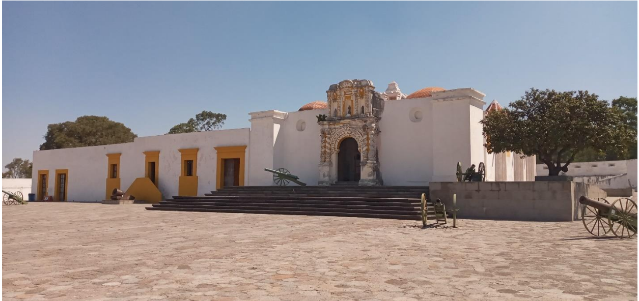
Fachada interior del Forte de Loreto. Fotografía propia, 2023.
