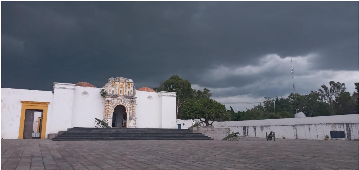
Fachada interior del Fuerte de Loreto. Fotografía propia, 2022.
