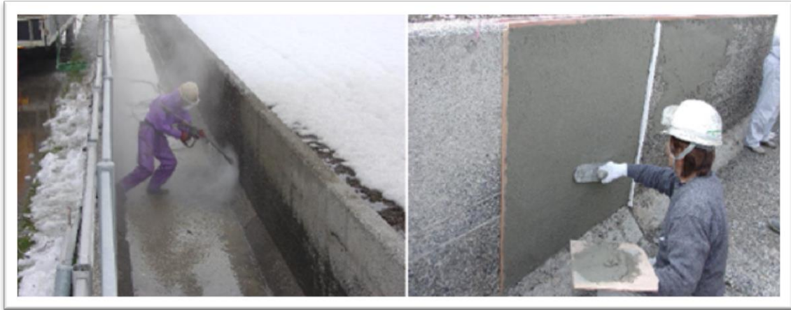
Figura 2. 6.Reparación de canales
