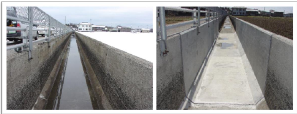
figura 2.6. a. Canales antes y después de reparación
