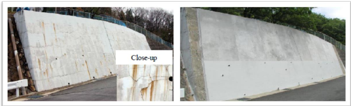
Figura 2. 7. A Muro de retención
