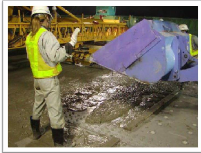
Figura 2.3. Colado en puente Mihara.
