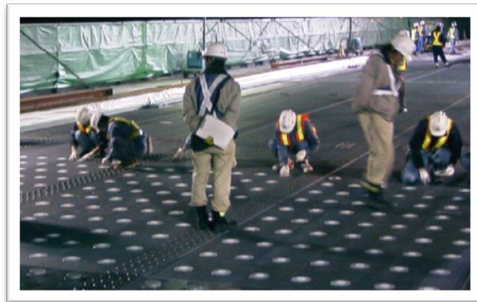
Figura 2. 2. Placas de unión en puente.
