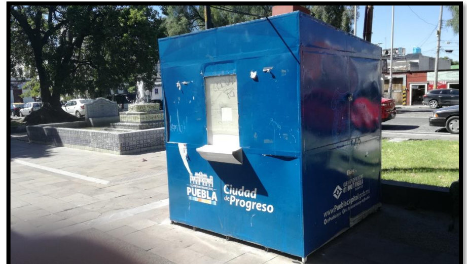
Módulo de cobro abandonado. (Morales, 2017)
