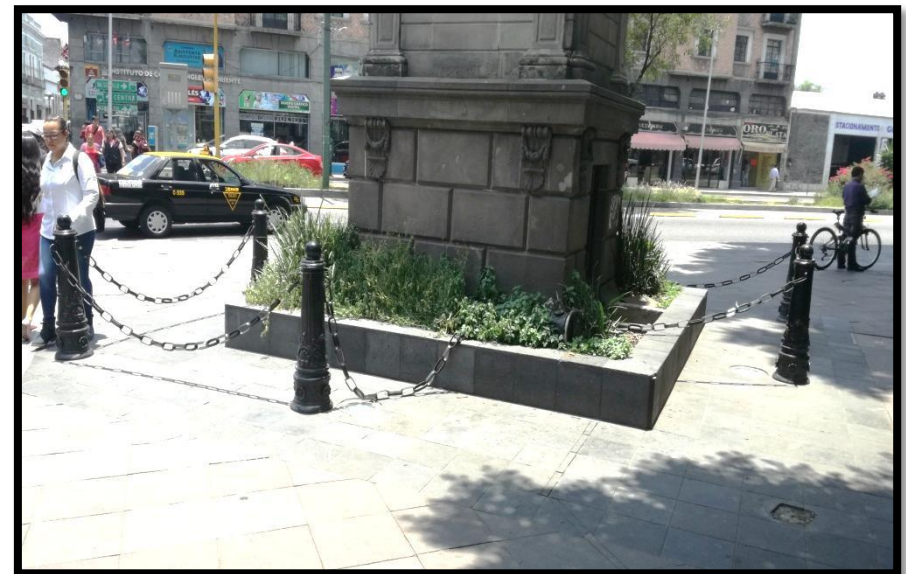
Poste de contención del gallito vandalizado. (Morales, 2017)
