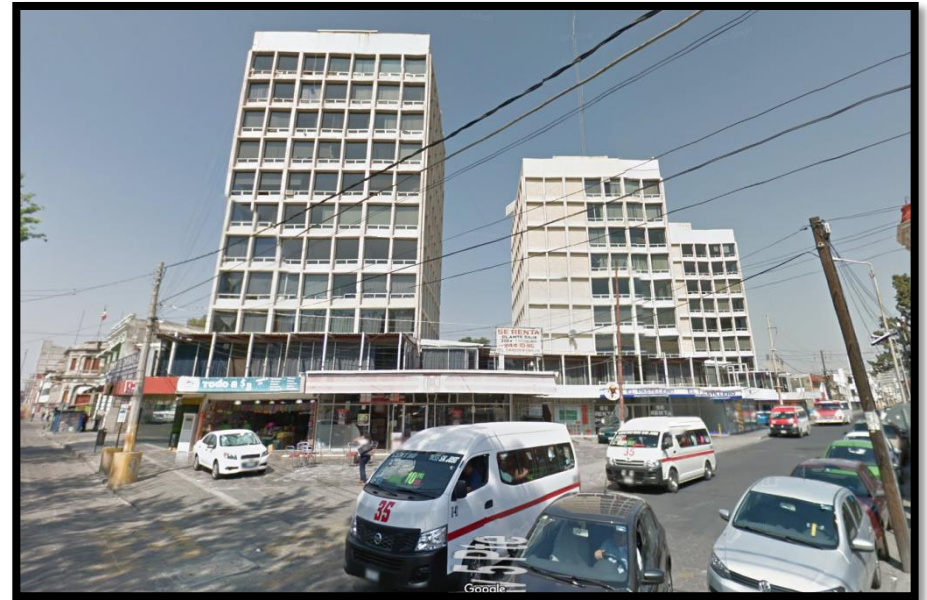
Procuraduría federal de protección al ambiente. Localización: Calle 5 Poniente 1303 (Google, 2017)
