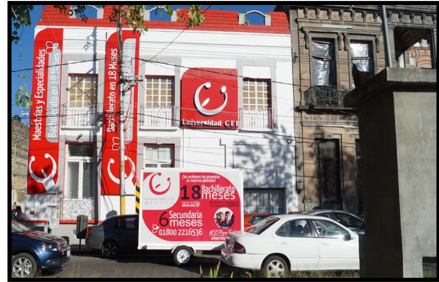
Universidad CEI México Plantel Centro. Localización: Calle 13 Sur 709. (Morales, 2017)
