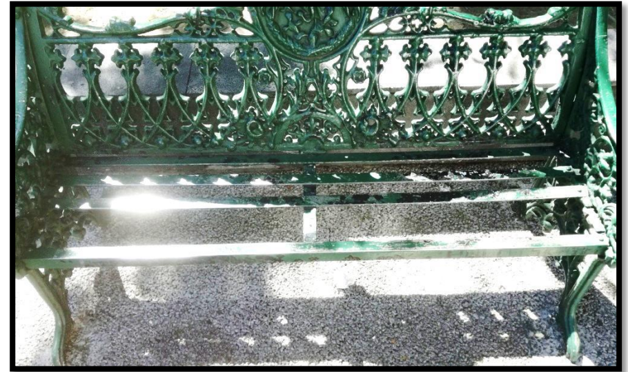
Bancos de hierro históricos vandalizados. (Morales, 2017)
