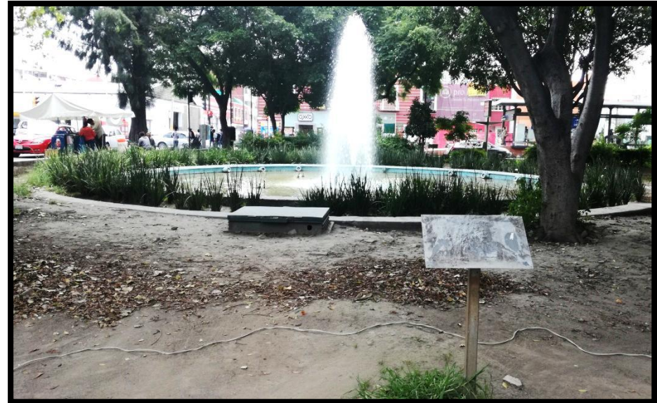
Robo de energía eléctrica, placa informativa vandalizada, área verde sin mantenimiento. (Morales, 2017)
