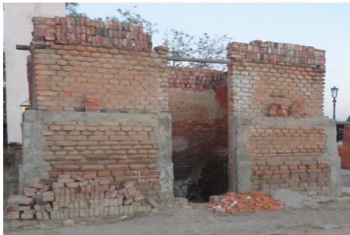
Imagen 1.3.3 Horno de tabiques y ladrillos. (Vera, 2013)
