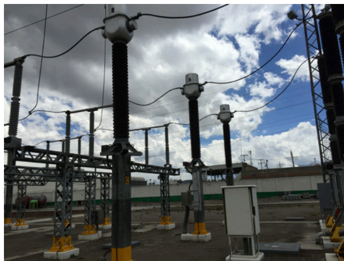
Fig. 3.5 Transformadores de corriente
