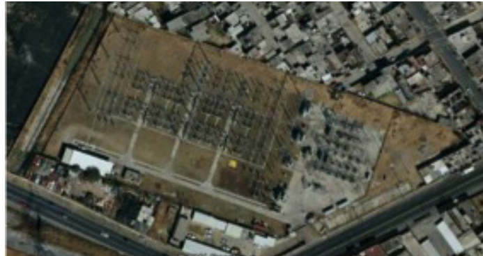
Fig. 2.1 Vista aérea de la S.E estadio
