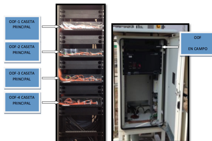
Fig. 5.12. ODF'S caseta principal y en MCAD'S de campo.
