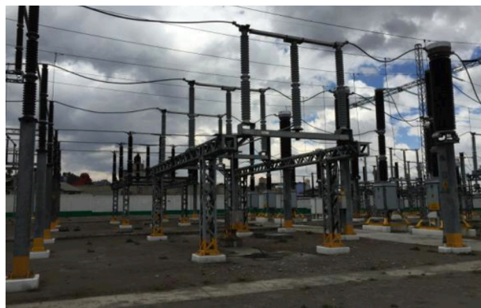
Fig. 3.3 Cuchillas 230 kv
