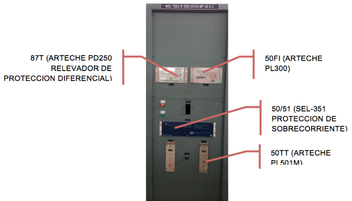
Fig. 4.4 Esquema de protecciones transformador est-t4 230/23 kv
