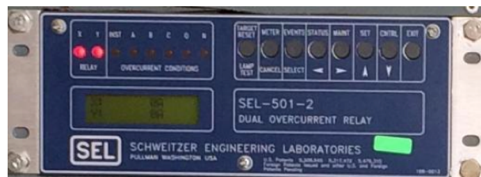
Fig. 4.11 Relevador de sobrecorriente dual.
