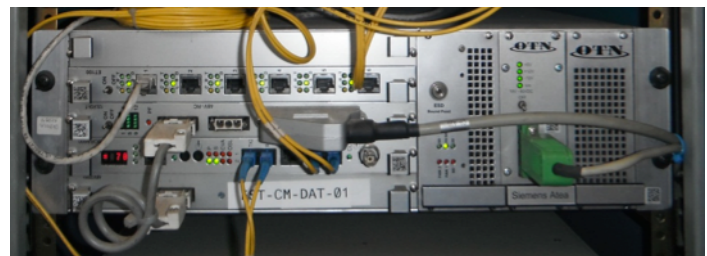
Fig. 6.4 Equipo Multiplexor PDH RFI IMUX2000 (Vista trasera)
