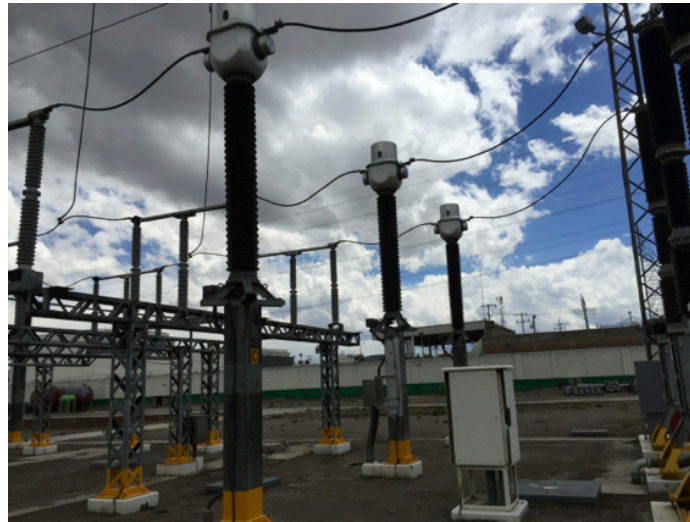
Fig. 3.6 Transformadores de corriente
