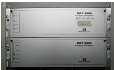
Fig. 6.3 Equipo Multiplexor PDH RFI IMUX2000 (Vista frontal)
