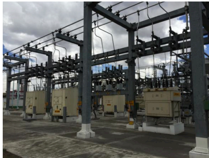
Fig. 3.8 Interruptores 23 kv
