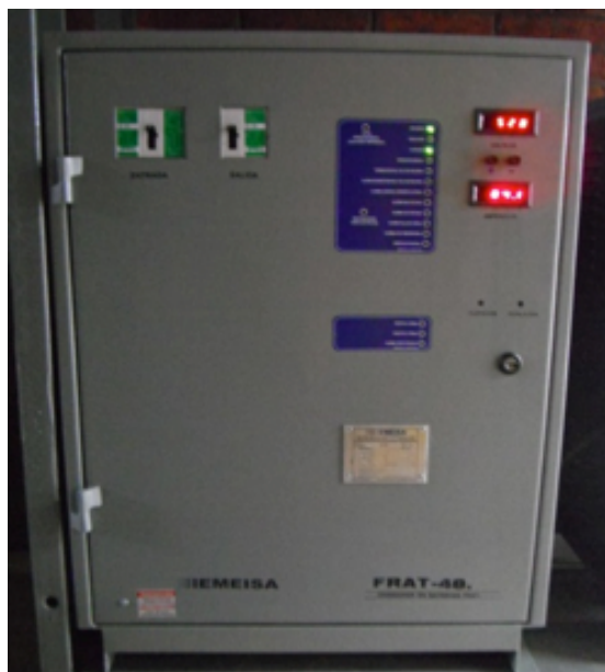
Fig. 6.9 Cargador de baterías
