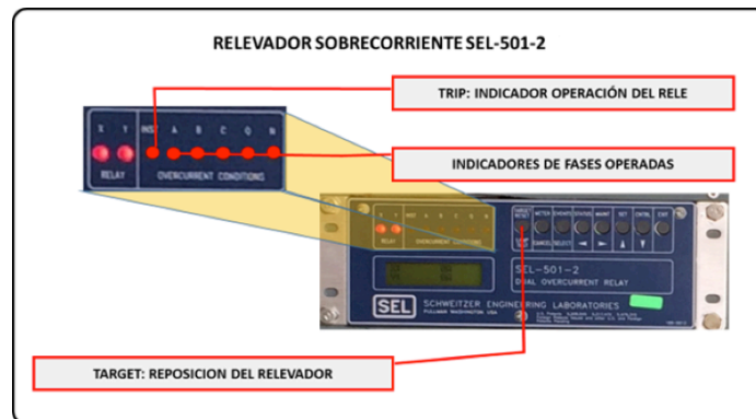
Fig. 4.13 Relevador de sobrecorriente SEL-501-2 (EST-T1, EST-T2 y EST-T3)
