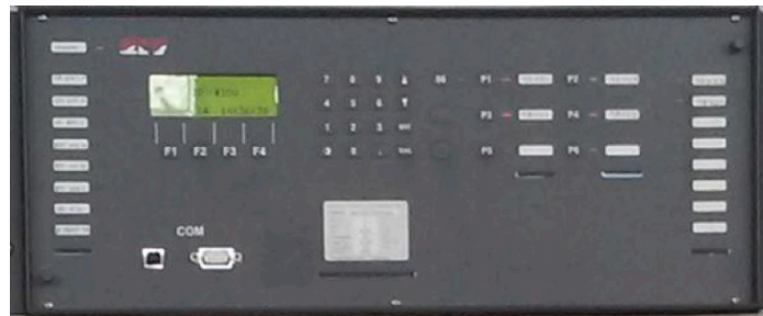
Fig. 4.6 Relevador de Protección Diferencial ZIV 387 8IDV (Protección 87T, EST-T1, EST-T2 Y EST-T3)
