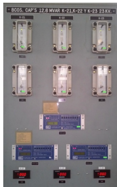
Fig. 4.29 Medidor (mod. Sel-501-2 para est-c1, est-c2, est-c3 y est-c4
