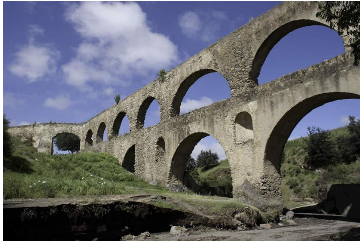
Imagen 4. Acueducto colonial. FOTOGRAFÍA: LMJ, 2013.
