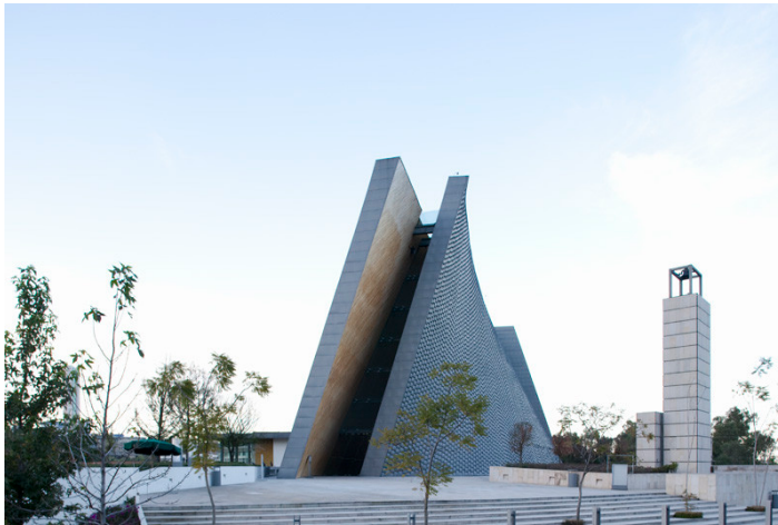
Imagen 6. Recuperada del portal Archdaily.com
