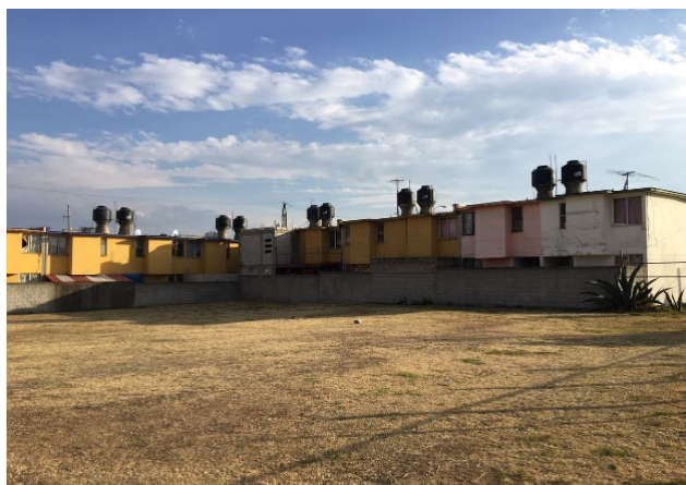
Imagen 21. Vista hacia el sur desde el interior del terreno. Fotografía por FDGP, 2017.
