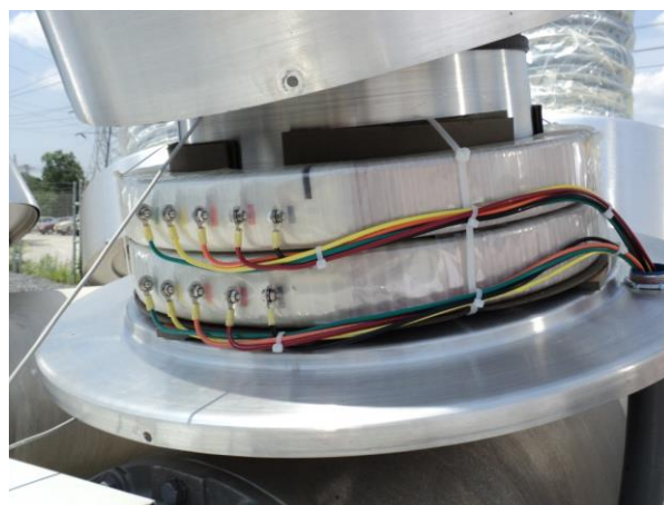
Figura 2.7. Transformador de corriente tipo boquilla o bushing.
