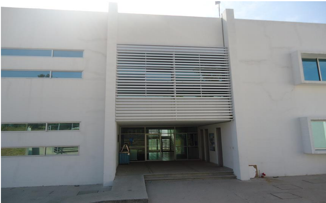
Fotografía 2. Fachada Edificio ATL 1
