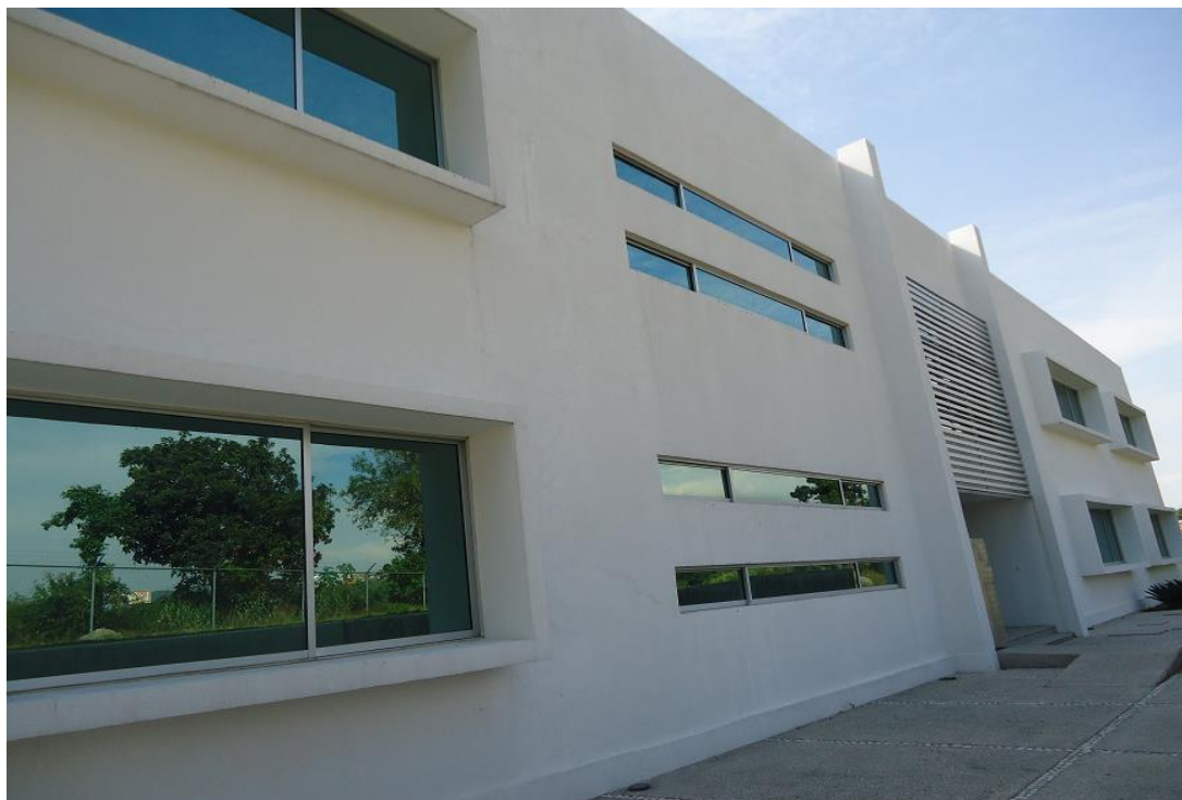
Fotografía 3. Fachada Edificio ATL 2
