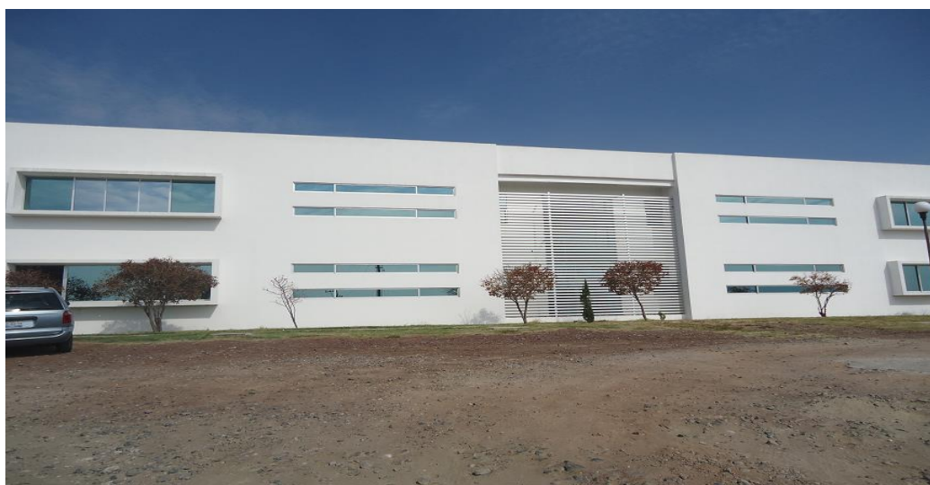
Fotografía 1. Acceso principal a la Unidad Regional Atlixco
