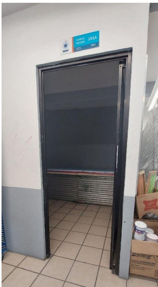
Figura 12. Entrada del cuarto oscuro. Fuente de elaboración propia.
