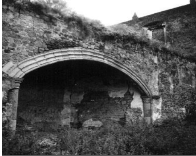
Figura 77 Imagen de la capilla abierta de Tepeyanco en 1940. Se aprecia su composición original antes de las intervenciones recientes.
