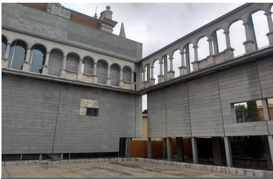
Figura 36 Detalle de la arcada frontal y lateral reintegradas en su posición original durante la etapa de intervención.
