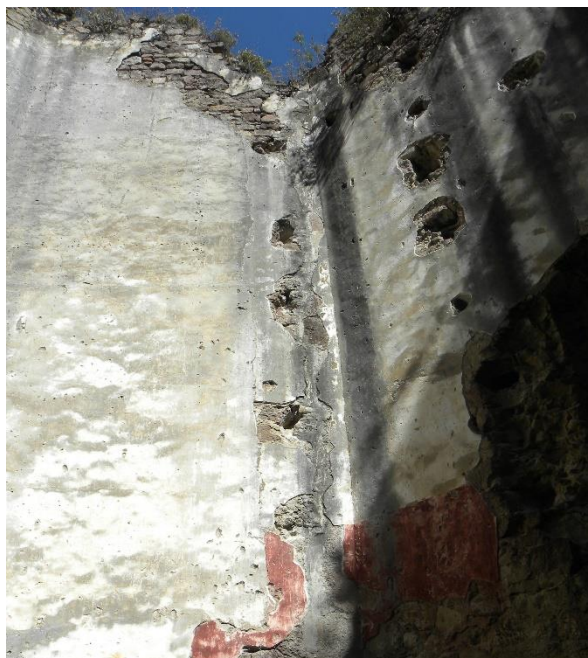
Figura 84 Configuración poligonal del ábside original, confirma la existencia de una bóveda de nervaduras. Se aprecian los mechinales de empotre del retablo.
