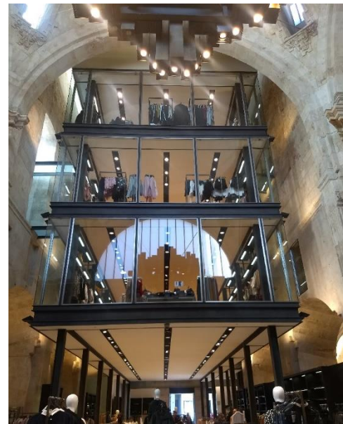
Figura 60 Detalle de módulo integrado en zona de la nave. Se aprecia su fabricación en materiales reversibles y la holgura correspondiente respetando la integridad de la estructura histórica
