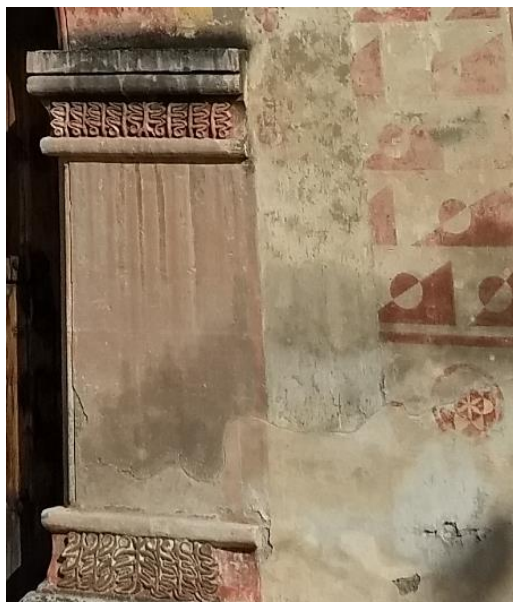
Figura 89 Representación de cuchillos lanceolados en impostas y basas de jambas en fachada principal.
