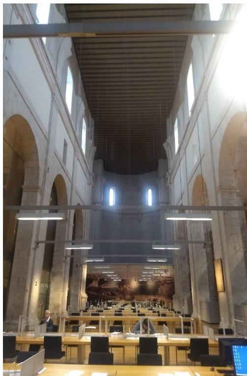
Figura 41 Archivo Municipal de Valladolid. Vista general de la nave reutilizada como sala de investigación.
