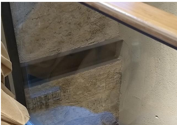
Figura 65 Detalle perimetral de anclaje de la nueva estructura sobre la preexistente. Se aprecia un procedimiento de intervención no invasivo.
