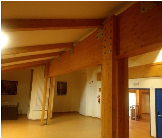
Figura 54 Detalle general de la estructura portante de graderías.
