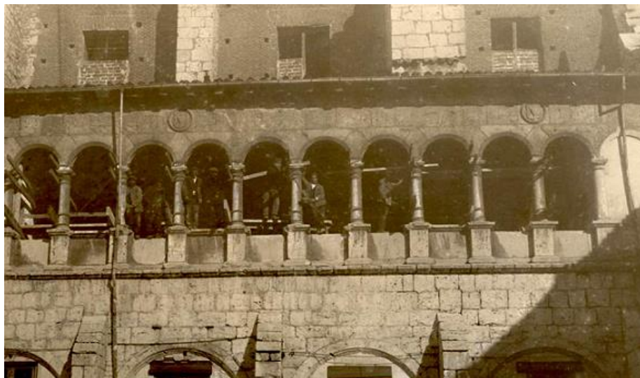
Figura 34 Aspecto de la arcada del Convento antes de ser retirada de su posición original
