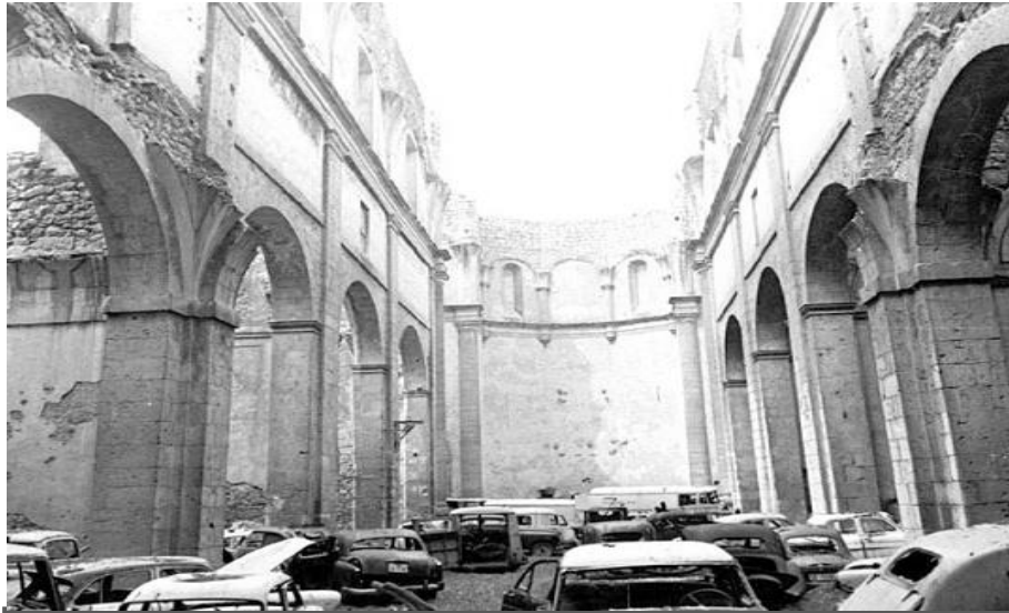
Figura 33 Ejemplo de usos inadecuados en la nave del templo conventual antes del proceso de intervención.
