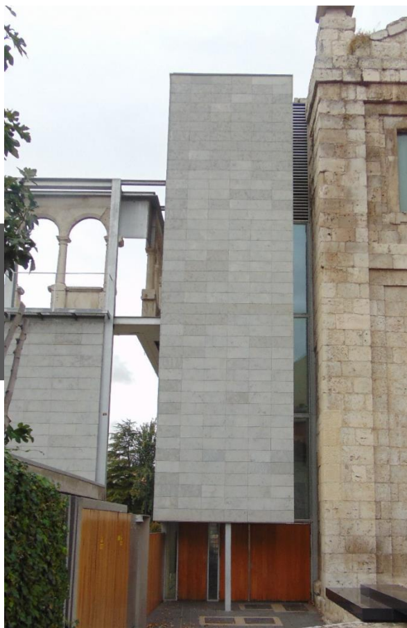
Figura 38 Detalle de la fachada frontal del nuevo módulo integrado. Se observa puerta de acceso, muro pantalla y cancelería al interior del cubo de luz.
