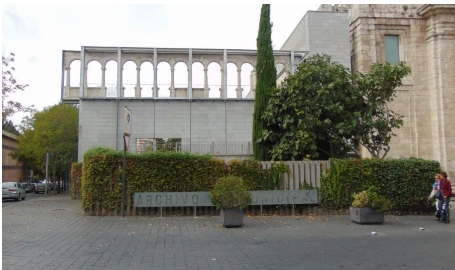
Figura 35 Detalle de la arcada frontal reintegrada en su posición original durante la etapa de intervención.
