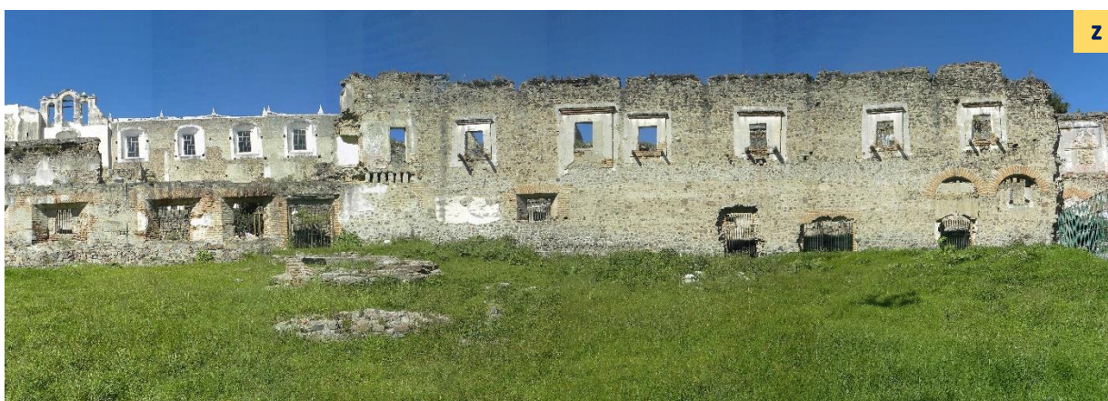
Figura 99 Reporte fotográfico del conjunto conventual. T: Ruina del convento, U-V: Refectorio, W: Cocina, X: Paramento sur del templo visto desde refectorio, Y: Vestigios de aljibe y corrales, Z: Larguillo del paramento sur del conjunto conventual.
