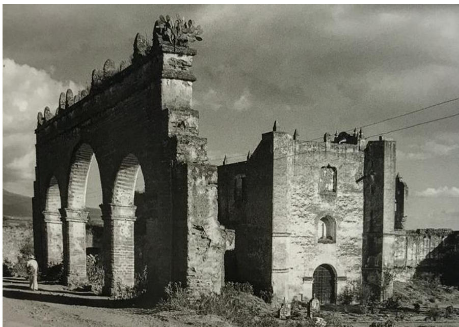
Figura 81 Imagen general del conjunto conventual en 1955, captada por Juan Rulfo.
