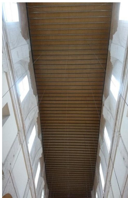
Figura 42 Detalle de la cubierta de la nave. Se observa la integración de nuevos materiales
