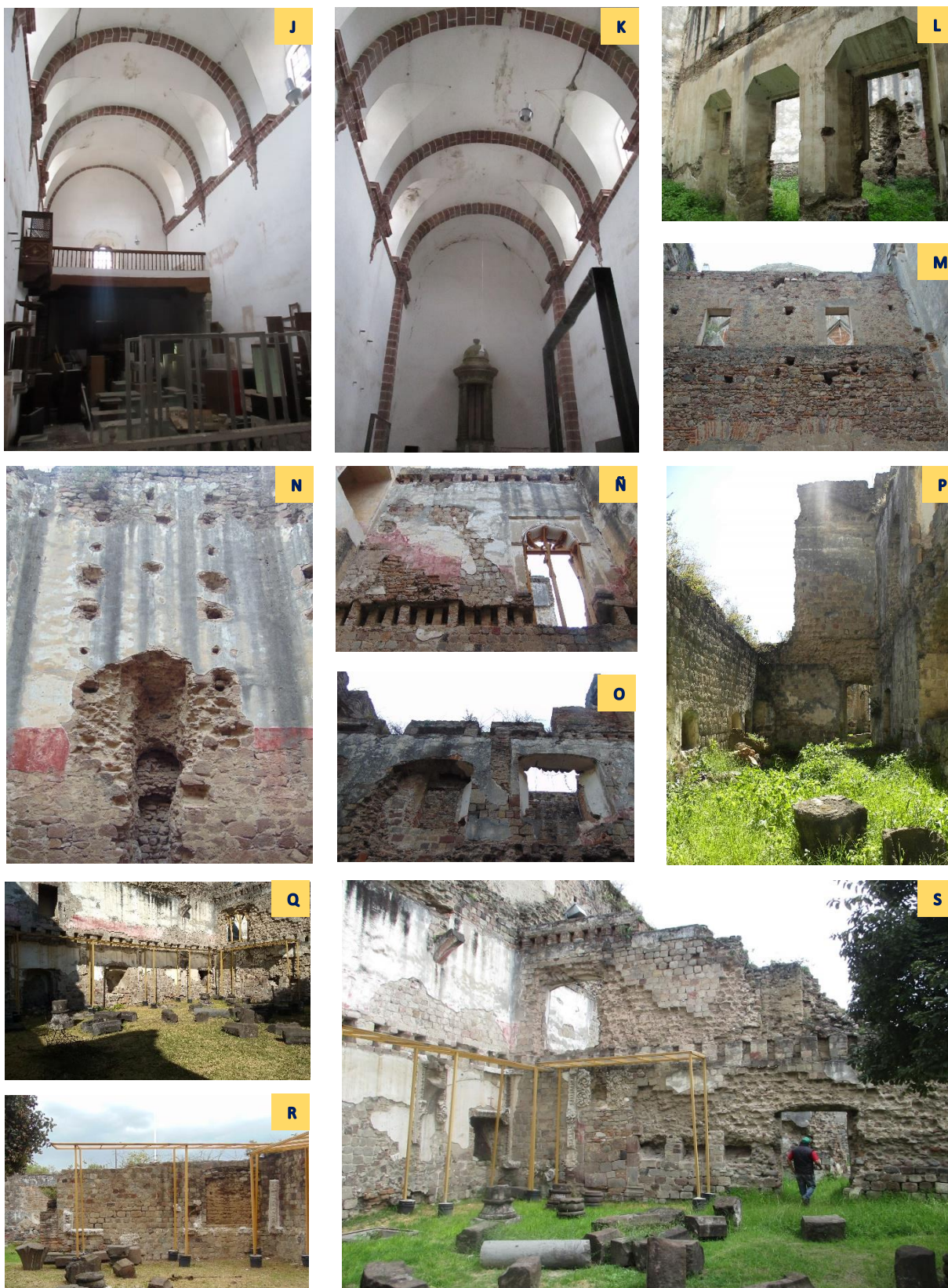
Figura 98 Reporte fotográfico del conjunto conventual. J-K: Interior del templo, L: Muro no original en antiguo presbiterio, M: Actual muro testero (no original), N: Antiguo ábside, Ñ-O: Vestigio de vanos derruidos en colecturía, P: Sala de profundis, Q-R-S: Ruinas del claustro bajo.
