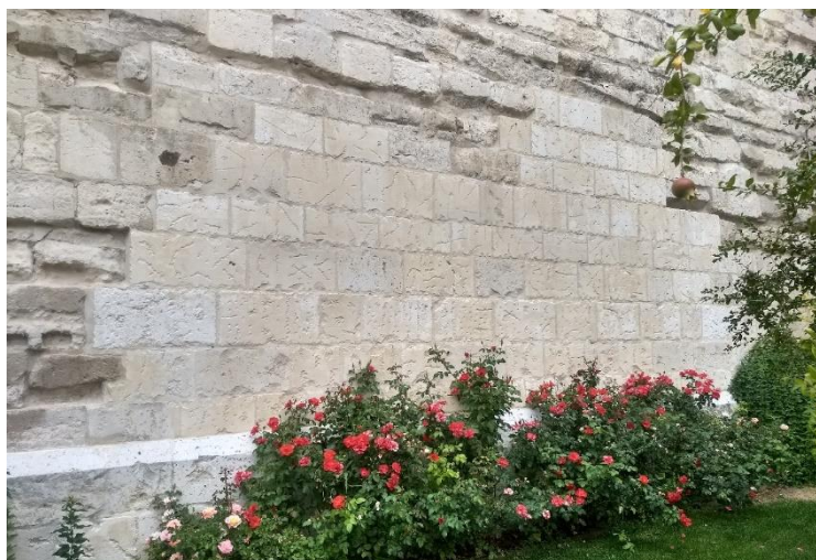
Figura 20 Diferenciación de nuevos materiales sobre la ruina durante la intervención en la Capilla de los Condes de Fuensaldaña.
