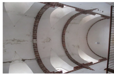
Detalle de materiales que configuran la cubierta y elementos adyacentes Interior Templo conventual
