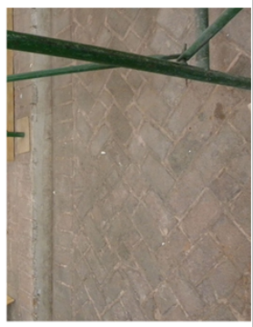
Detalle de materiales que configuran el pavimento. Interior Templo conventual
