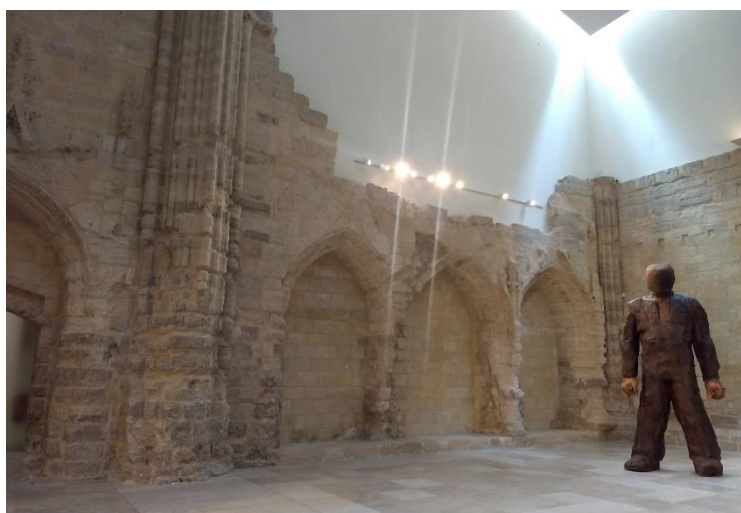
Figura 24 Vista interior de la capilla de los Condes de Fuensaldaña. Se aprecia la integración de muros con material contemporáneo sobre los preexistentes.
