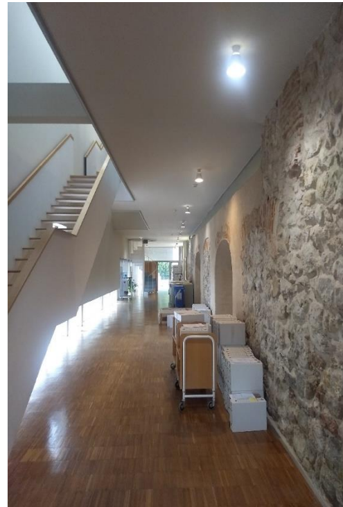
Figura 45 Vista interior del nuevo edificio, se observa el detalle del muro colindante con el antiguo templo
