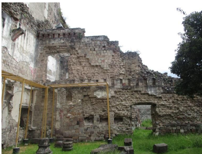
Figura 1 Estado ruinoso actual del Conjunto Conventual de San Francisco Tepeyanco.
