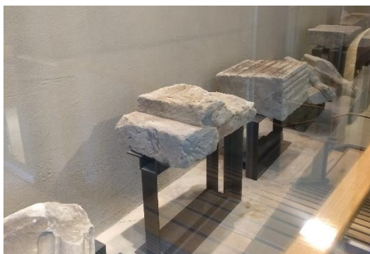
Figura 69 Detalle de piezas extraídas para el sistema de anclaje, respetadas y exhibidas dentro del inmueble
