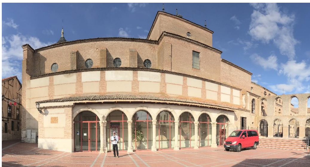
Figura 50 Vista lateral del antiguo templo del Ex convento de la Merced de Olmedo, hoy Centro de artes escénicas San Pedro
