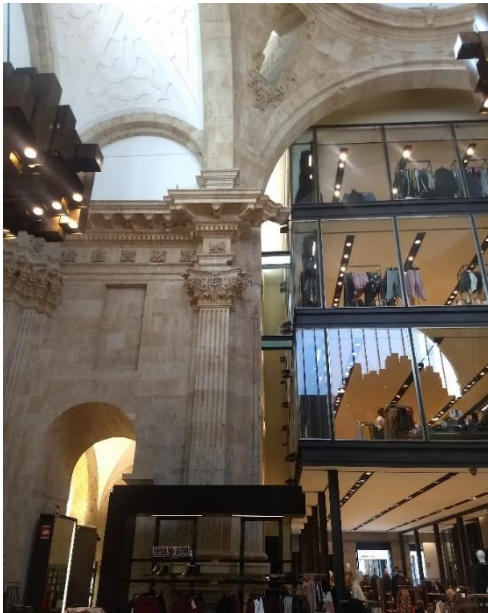
Figura 61 Vista de la integración del nuevo módulo a la estructura existente.
