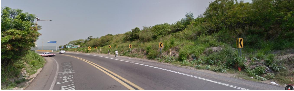
Imagen 31. Carretera Federal 180 (Acceso secundario). Google Maps (2020)
