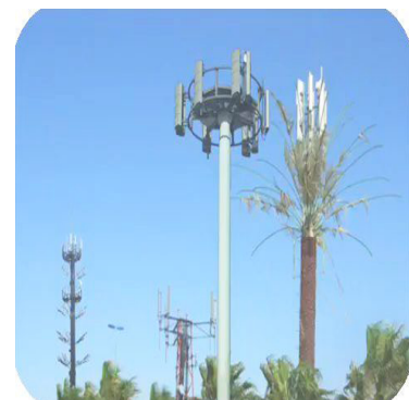
(f) Torre tipo mástil
