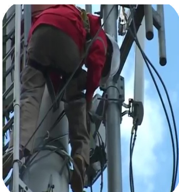
(d) Colocación de puente.
