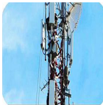
(e) Torre arriostrada
