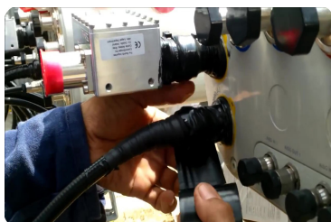
(d) Colocación cinta aislante
