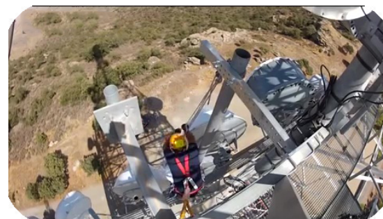
(c) Bajando antena sectorial
