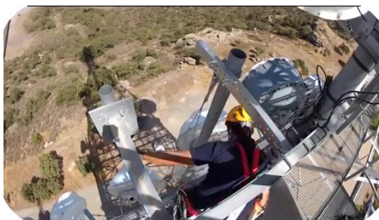
(b) Desinstalación de sector
