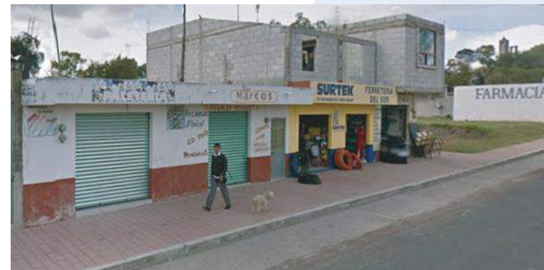
Fotografía 18. Estado actual de vivienda de la calle Miguel Hidalgo entre 3 Y 5 poniente
