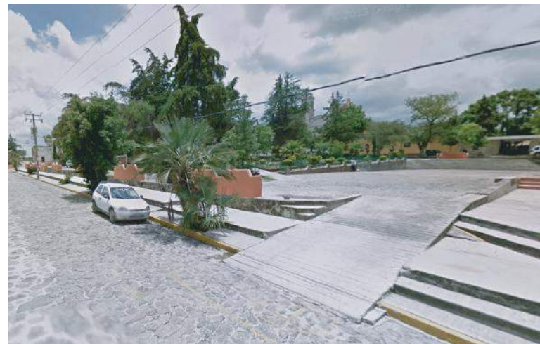
Fotografía 22. Estado actual del costado del zócalo, avenida Gonzalo Bautista.
