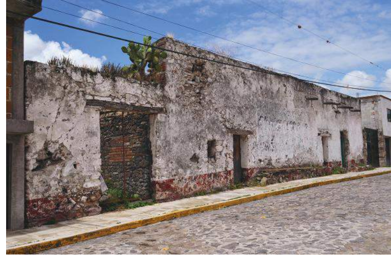
Fotografía 5. Construcción ubicada en la avenida Gonzalo Bautista.
