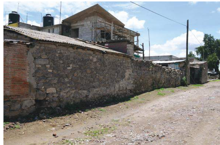
Fotografía 13. Construcción ubicada en la calle 3 poniente.
