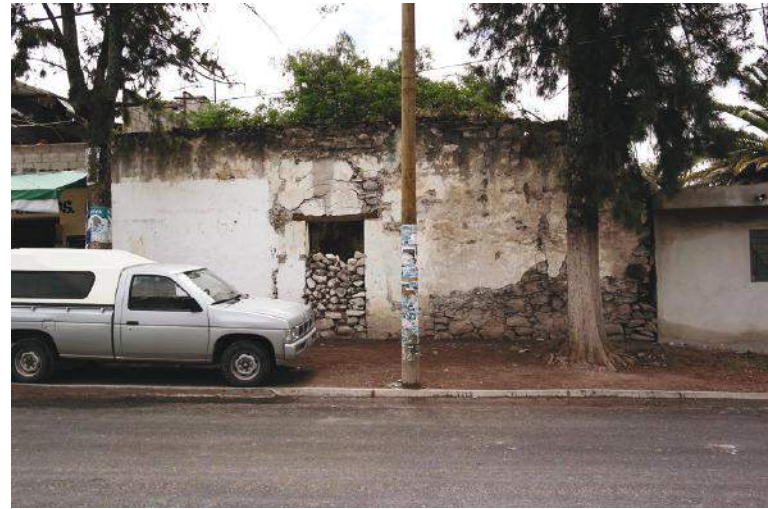
Fotografía 9. Construcción ubicada en la calle Miguel Hidalgo, entre la calle Gonzalo Bautista y avenida 3 oriente.
