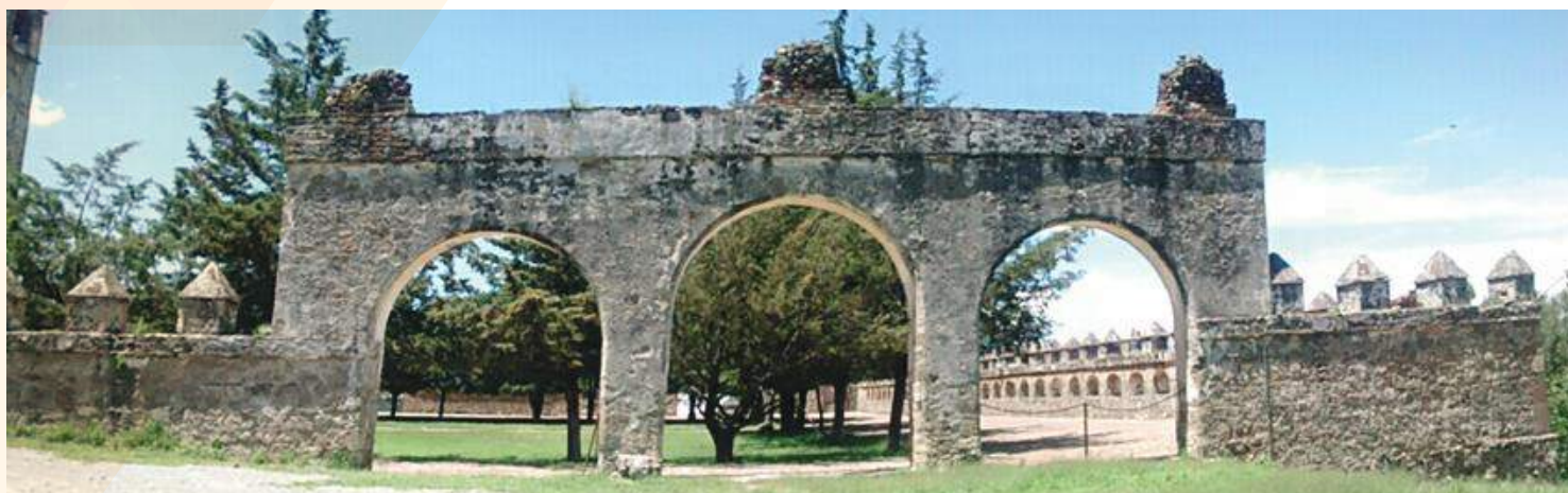
Fotografía 33. Barda atrial del ex-convento Franciscano por avenida 2 Poniente, 2014.
