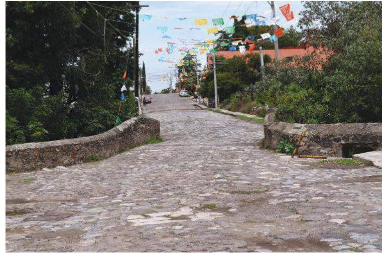
Fotografía 2. Puente de Cuauhtinchan.
