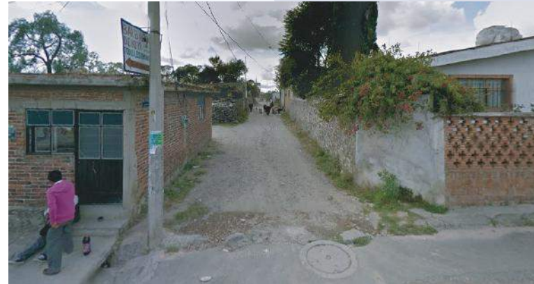
Fotografía 20. Estado actual de la calle 3 poniente.
