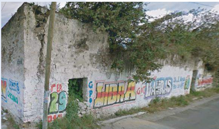
Fotografía 19. Estado actual de construcción del siglo XVI.
