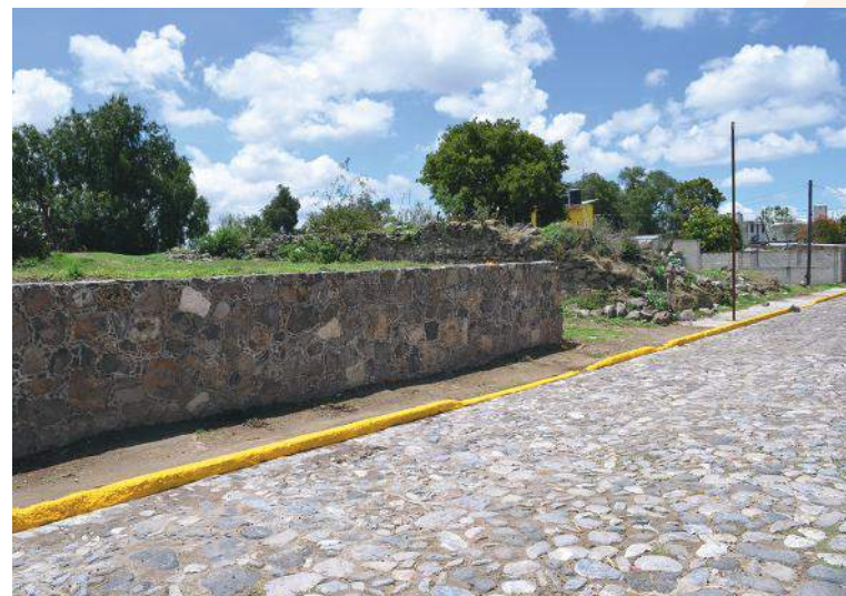
Fotografía 16. Restos de construcción ubicados en la calle 3 sur.
