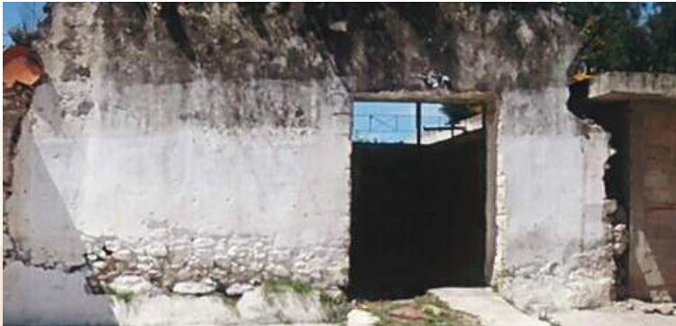
Fotografía 11. Vivienda ubicada en la calle Gonzalo Bautista.
