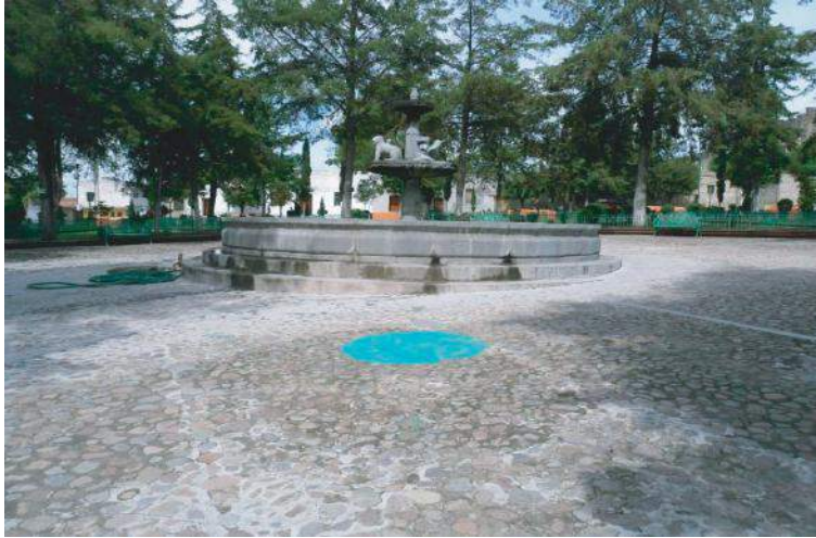
Fotografía 23. Estado actual del interior del zócalo.
