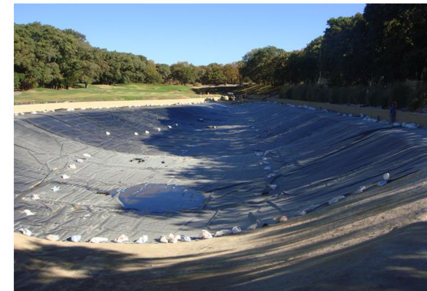
25.- Fotografía ejemplo Geomembrana 48
