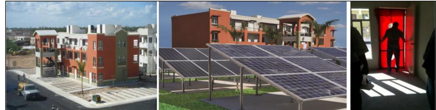
8.- Vivienda Vertical en Cancún, Guerrero 23 .
