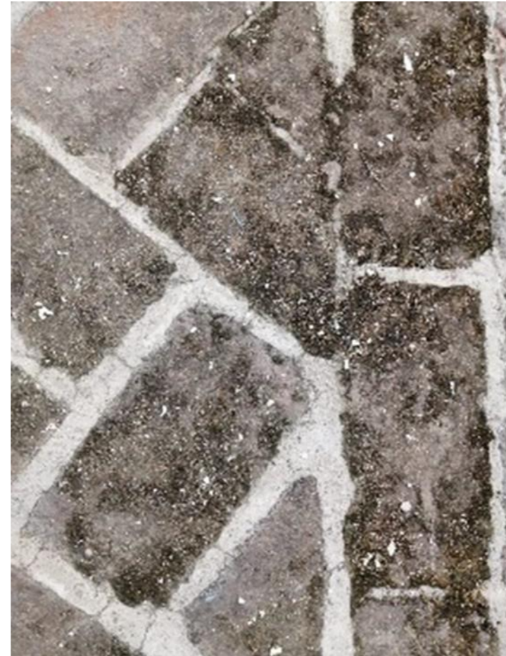
Detalle en piso de cantera exterior: Gabriel Enríquez Zenteno, Agosto 2022
