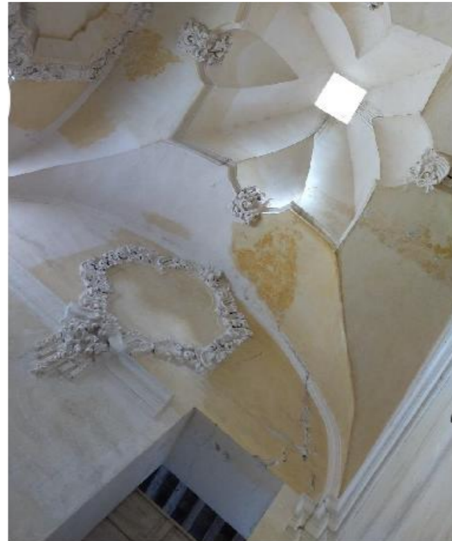
Cubo de escaleras principales y acceso a primer nivel: Gabriel Enríquez Zenteno, Agosto 2022
