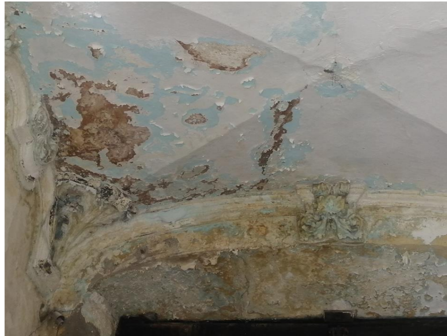
Detalle en bóveda, fotografía: Gabriel Enríquez Zenteno, Agosto 2022
