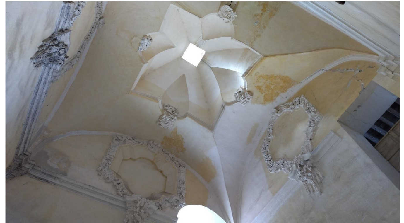
ILUSTRACIÓN 41 GARCÍA, H. I. (2022). CUBO DE LAS ESCALERAS PRINCIPALES. 8 ORIENTE #401, CENTRO, PUEBLA, MÉXICO. [FOTOGRAFÍA].
