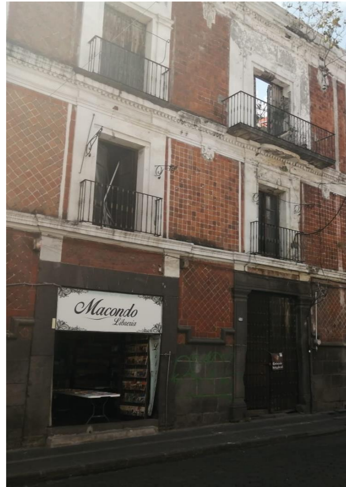
Fachada principal, fotografía: Gabriel Enríquez Zenteno, Agosto 2022
