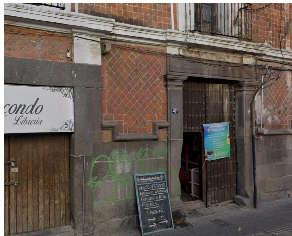
ILUSTRACIÓN 37 GARCÍA, H. I. (2022). ACCESO PRINCIPAL 8 ORIENTE #401, CENTRO PUEBLA, MÉXICO. [FOTOGRAFÍA].
